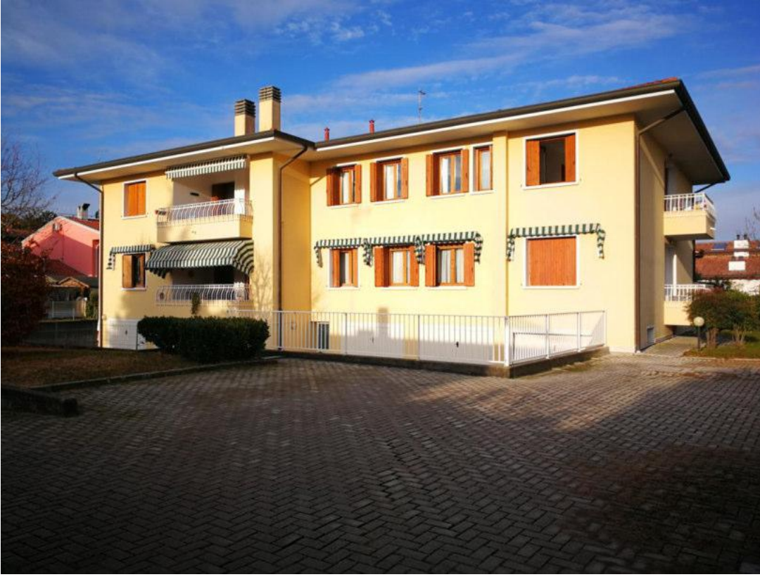
FOTO N.01 FOGLIO 32, MAPPALE 1542, SUB.2 COMUNE DI AZZANO DECIMO (PN)
