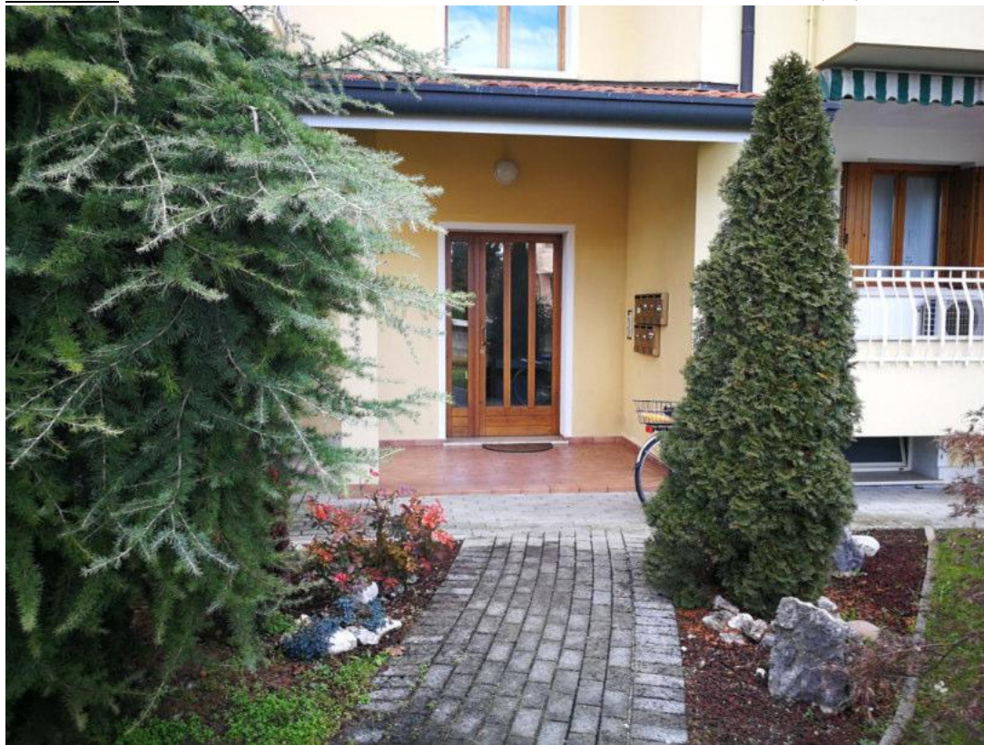
FOTO N.08 FOGLIO 32, MAPPALE 1542, SUB.2 COMUNE DI AZZANO DECIMO (PN)
