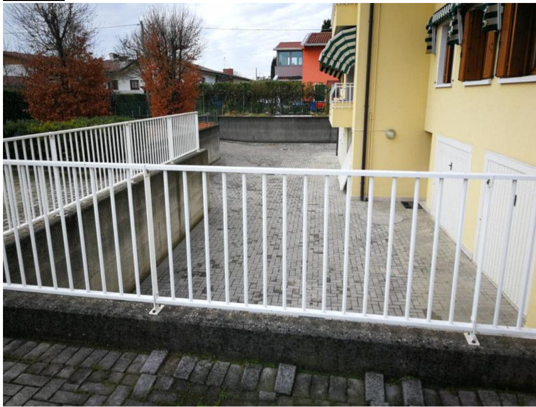
FOTO N.07 FOGLIO 32, MAPPALE 1542, SUB.2 COMUNE DI AZZANO DECIMO (PN)
