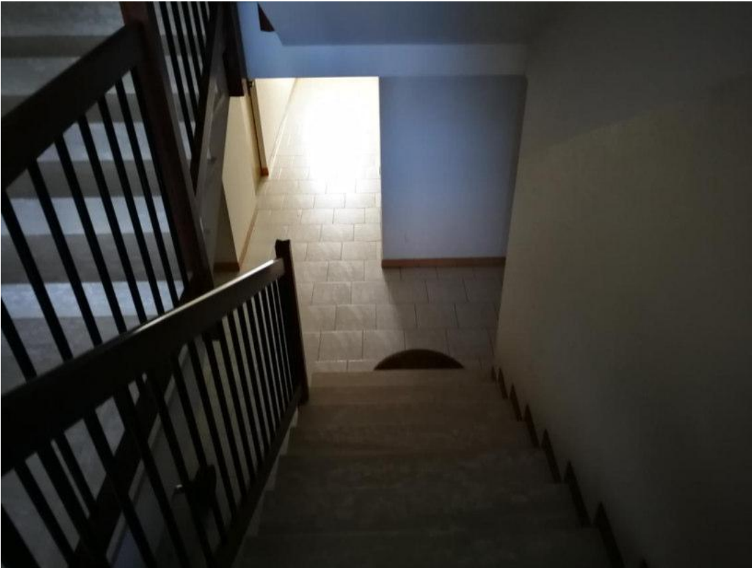
FOTO N.15 FOGLIO 32, MAPPALE 1542, SUB.2 COMUNE DI AZZANO DECIMO (PN)
