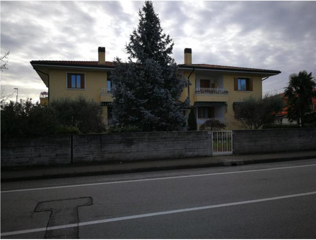
FOTO N.03 FOGLIO 32, MAPPALE 1542, SUB.2 COMUNE DI AZZANO DECIMO (PN)
