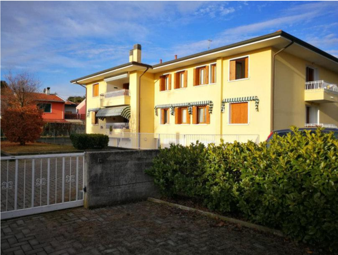
FOTO N.02 FOGLIO 32, MAPPALE 1542, SUB.2 COMUNE DI AZZANO DECIMO (PN)
