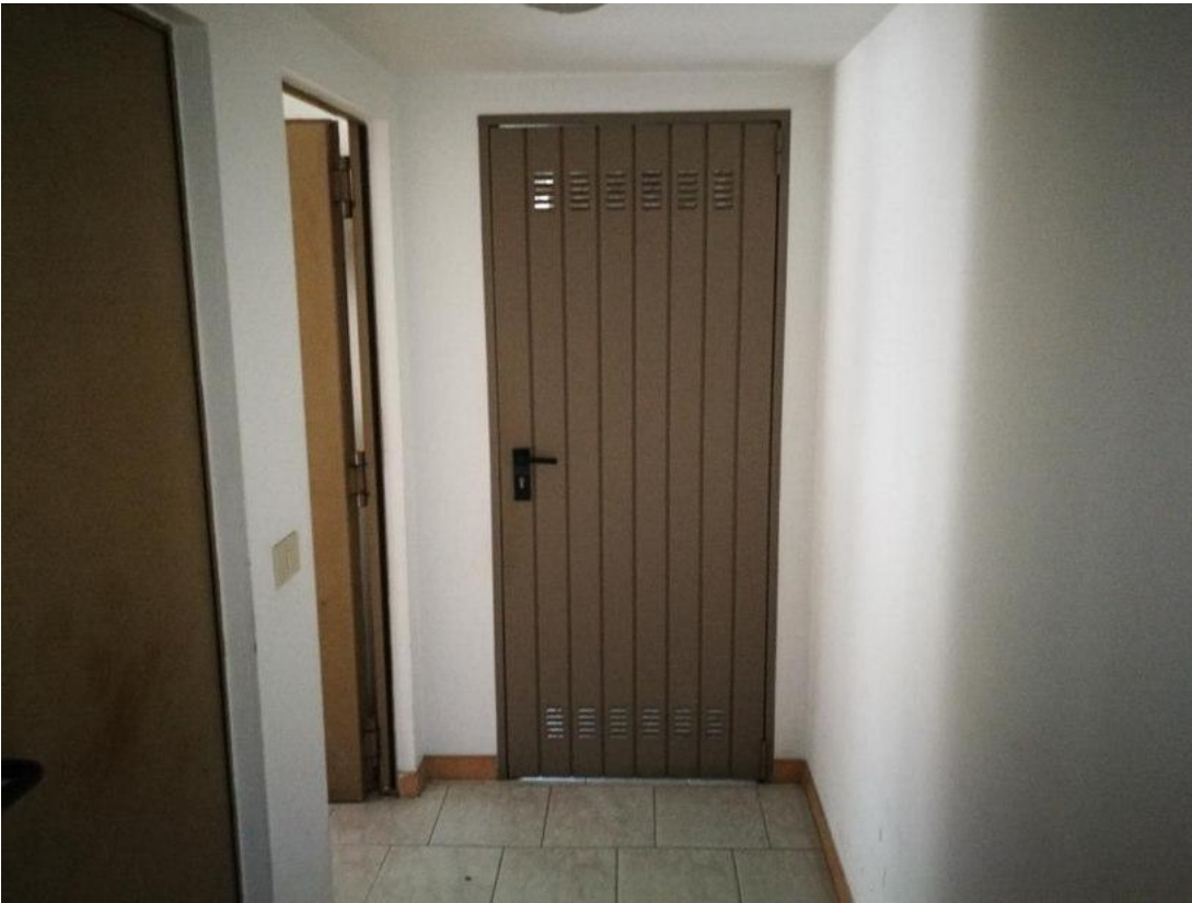
FOTO N.16 FOGLIO 32, MAPPALE 1542, SUB.2 COMUNE DI AZZANO DECIMO (PN)
