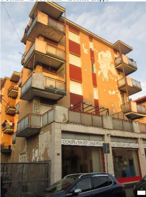
3 Lato Via Monte Grappa
