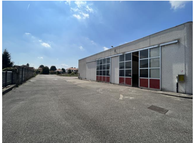
Vista dal cortile della porzione di capannone e dell'area di pertinenza
