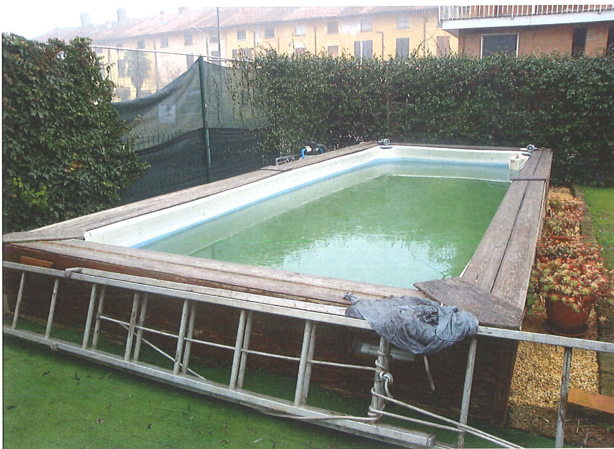
R.G.E. 388/2021 G. E. Dott.ssa M.G. Mennuni Gorgonzola, Via Per Cascina Antonietta n.°31, Foglio 12, mapp. 355, sub. 1 Prospetti esterni: il portico all'ingresso della villa e la vasca nel giardino
