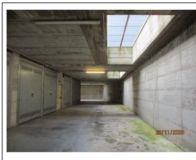
Corsello di manovra
