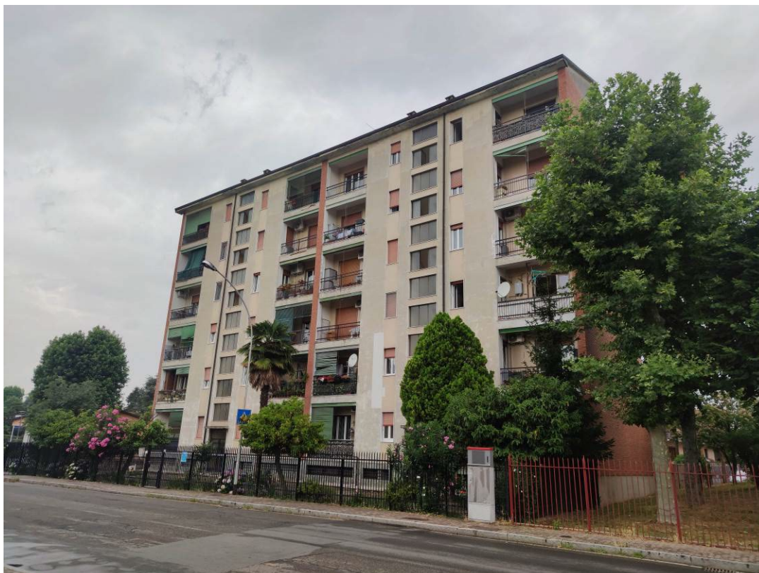
Immagine. 1. Vista da strada
