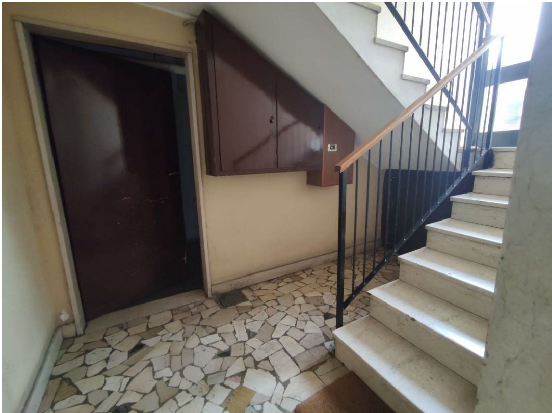
Immagine. 12. Scala comune accesso al piano cantine
