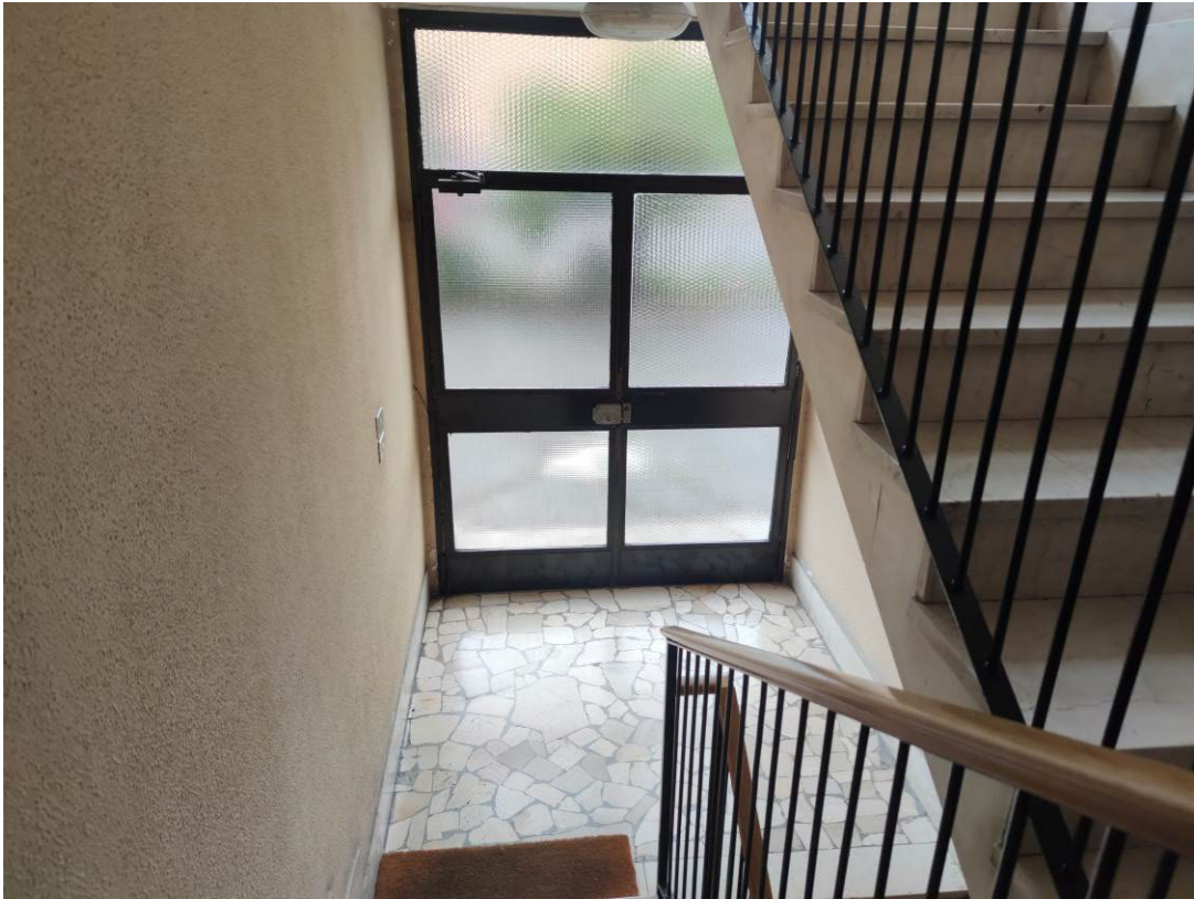
Immagine. 3. Scala comune di accesso. Vista portone di ingresso.
