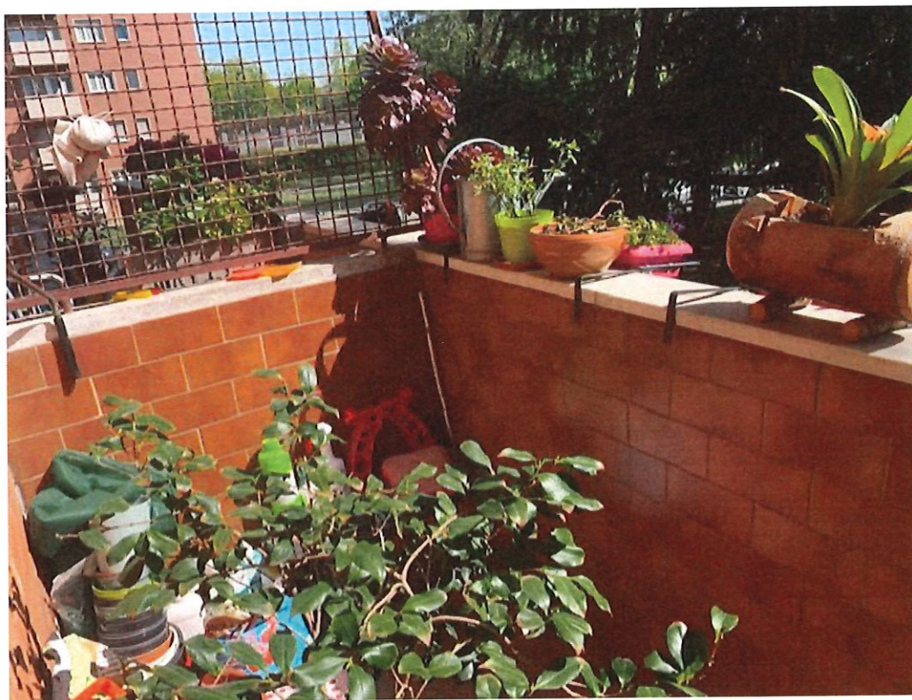
VISTA ESTERNA - BALCONE
