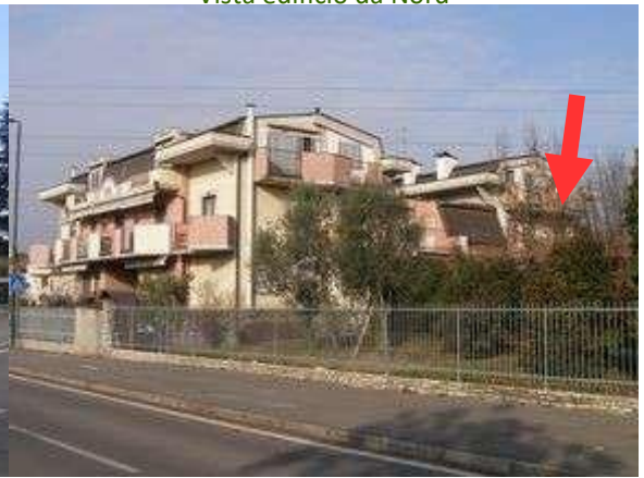
Vista edificio da Sud Ovest
