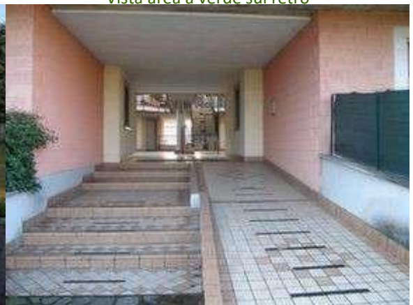
Vista ingresso corte interna
