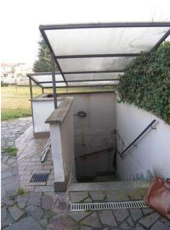
Vista ingresso pedonale ai box
