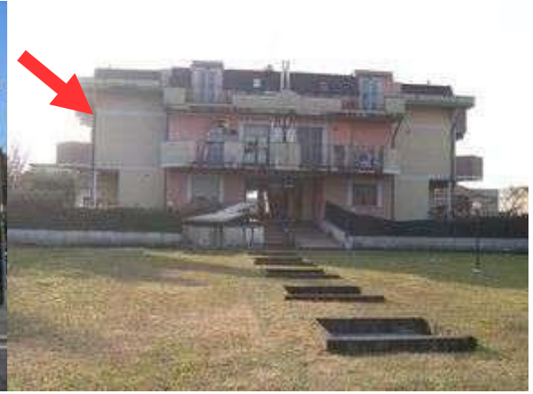
Vista edificio da Nord
