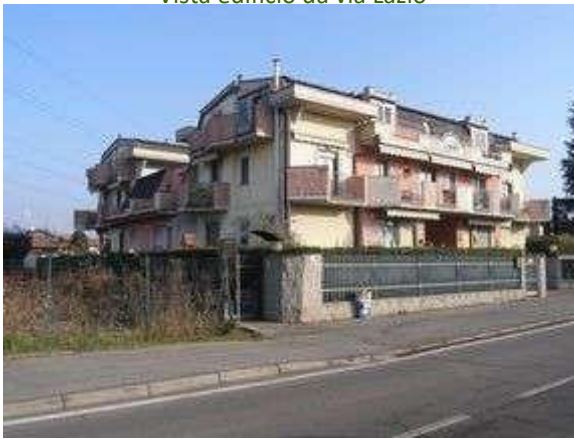
Vista edificio da Sud Est
