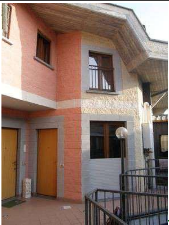
Vista da corte interna
