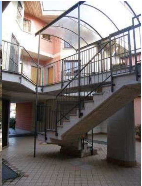
Vista corte interna
