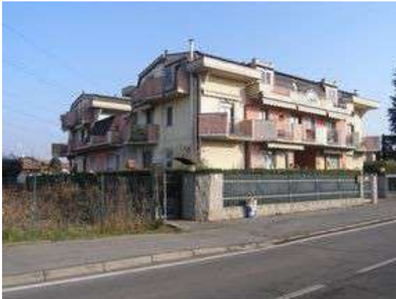
Vista edificio da Sud Est
