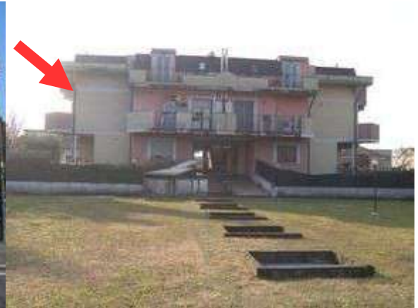
Vista edificio da Nord
