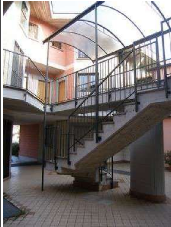
Vista da corte interna
