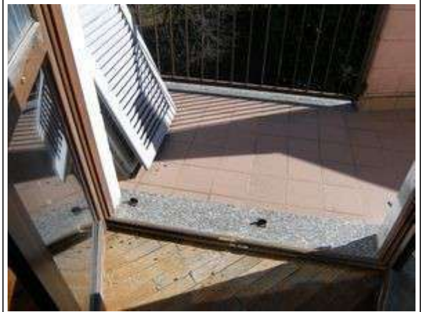
Dettaglio pavimento verso balcone piano 2
