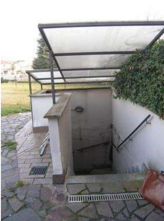
Vista ingresso pedonale ai box
