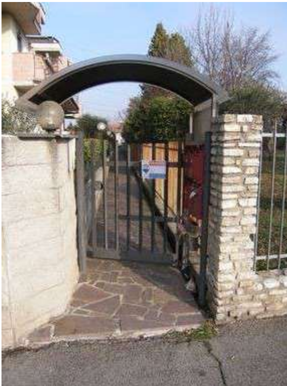
Vista accesso pedonale su strada
