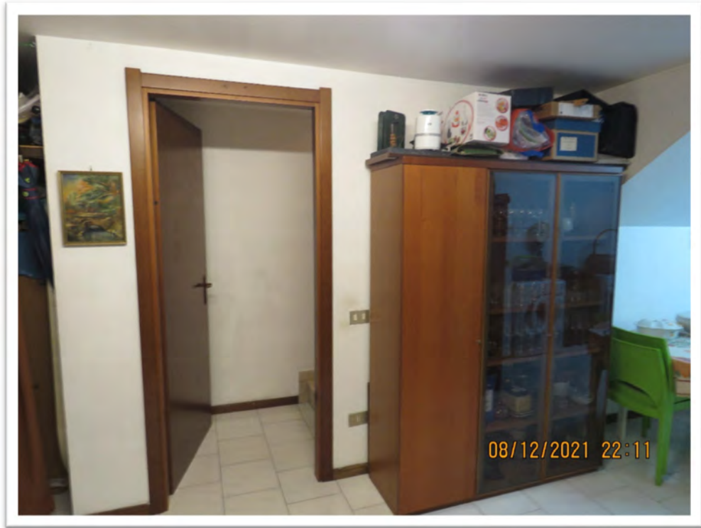
L'autorimessa: viste della porta che conduce al vano scala che conduce al piano rialzato e vista del ripostiglio.
