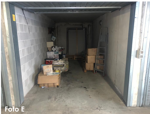
Foto E –Veduta interna del BOX
