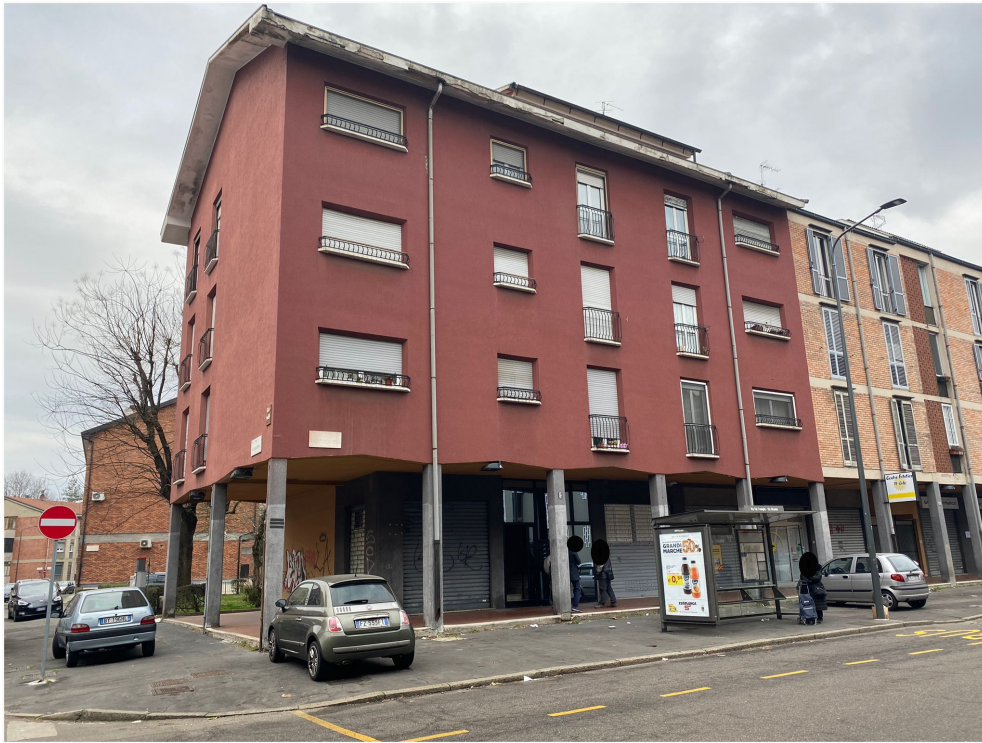
Foto n. 1 – Prospetto del fabbricato
