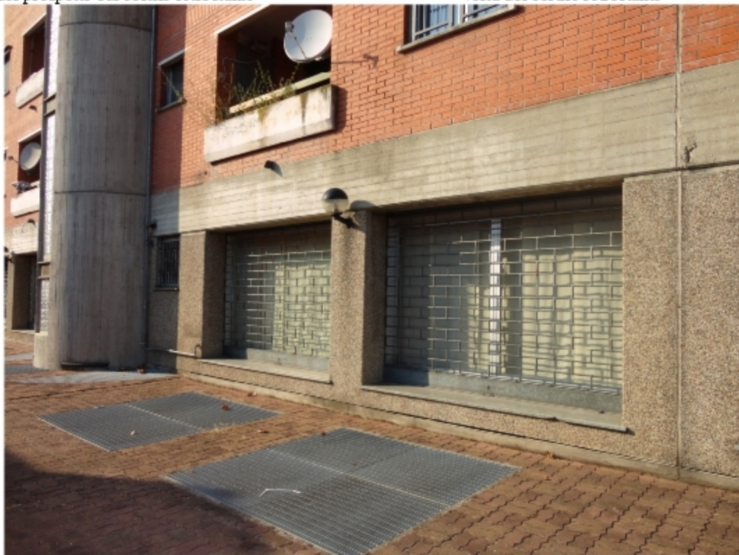
Vista delle finestre dell'unità immobiliare dal cortile retrostante
