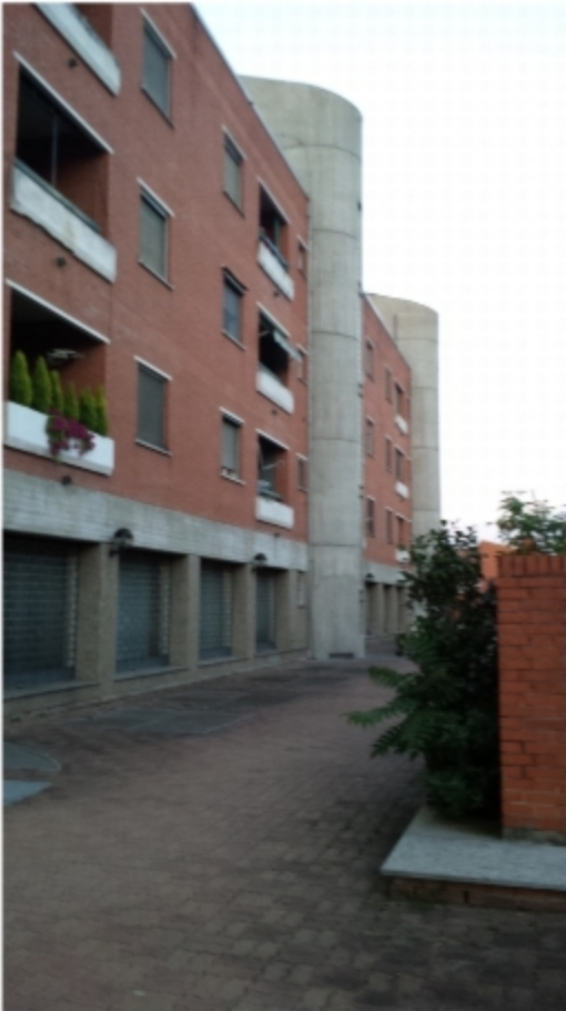
Vista del prospetto sul cortile retrostante
