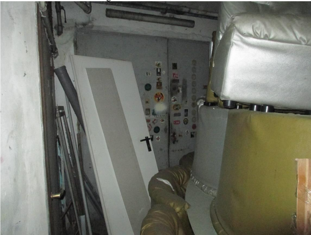
Foto 10: locale adibito a magazzino
