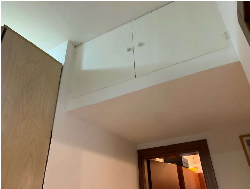
Fotografia n. 11 – Particolare del ribassamento realizzato nel locale disimpegno in corrispondenza dei locali camera da letto e bagno
