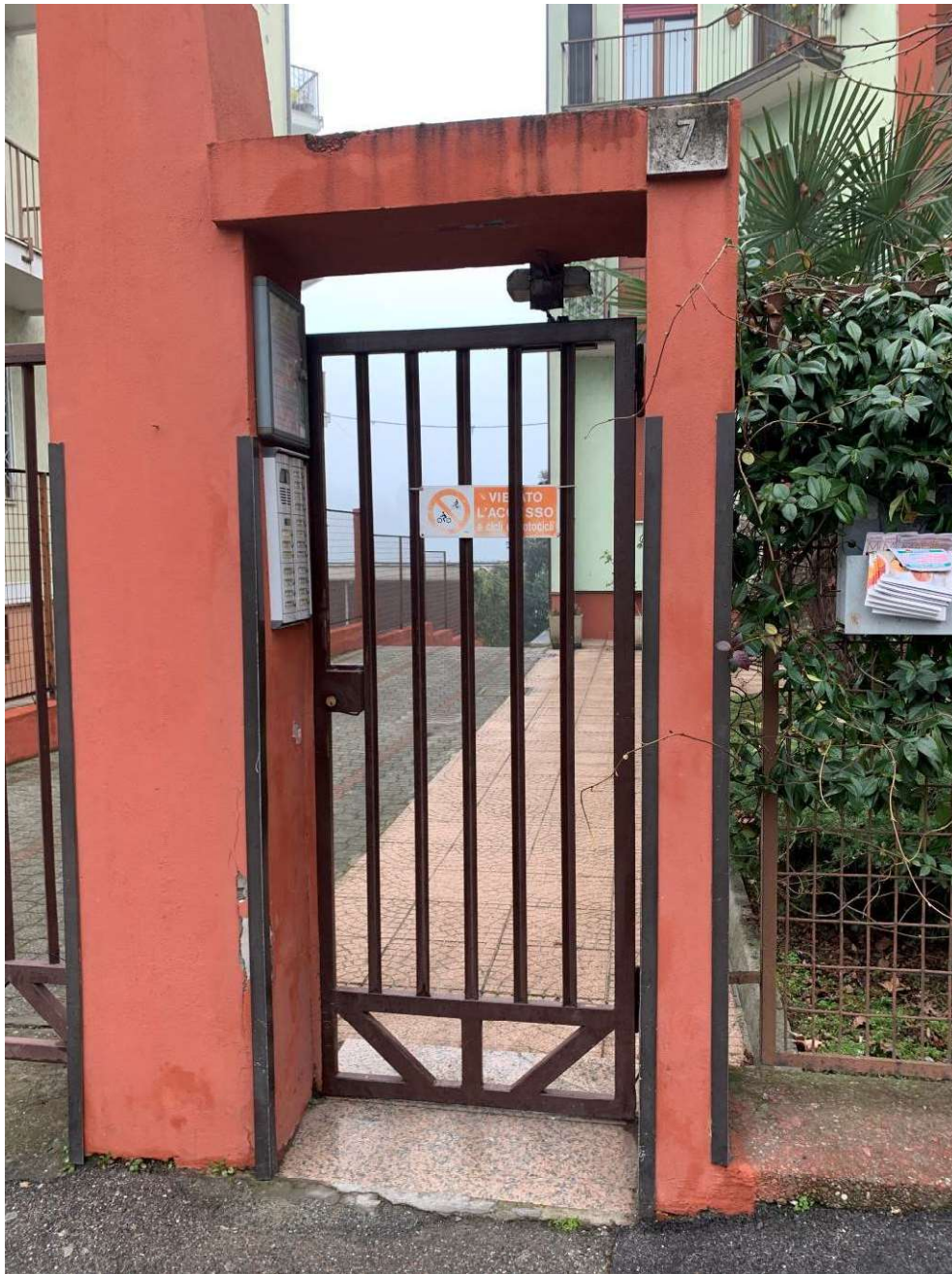
Fotografia n. 2 – Particolare del cancello di ingresso pedonale
