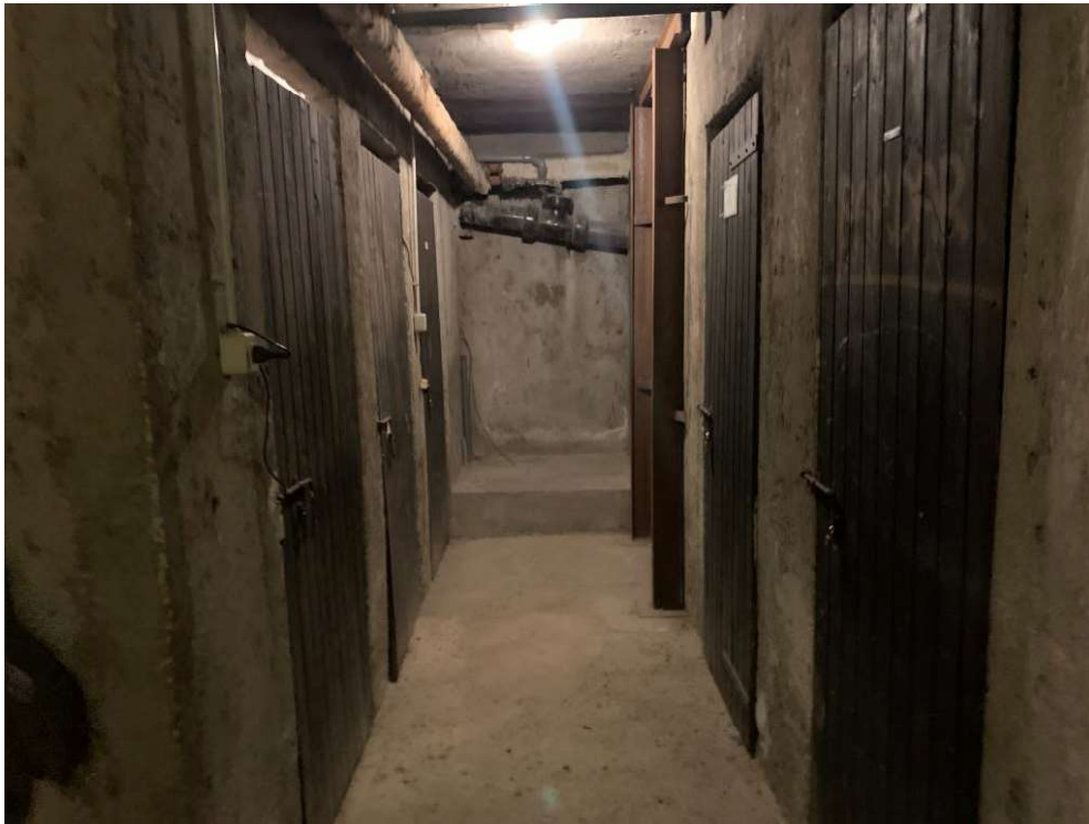
Fotografia n. 25 – Vista del corridoio di accesso ai locali cantina
