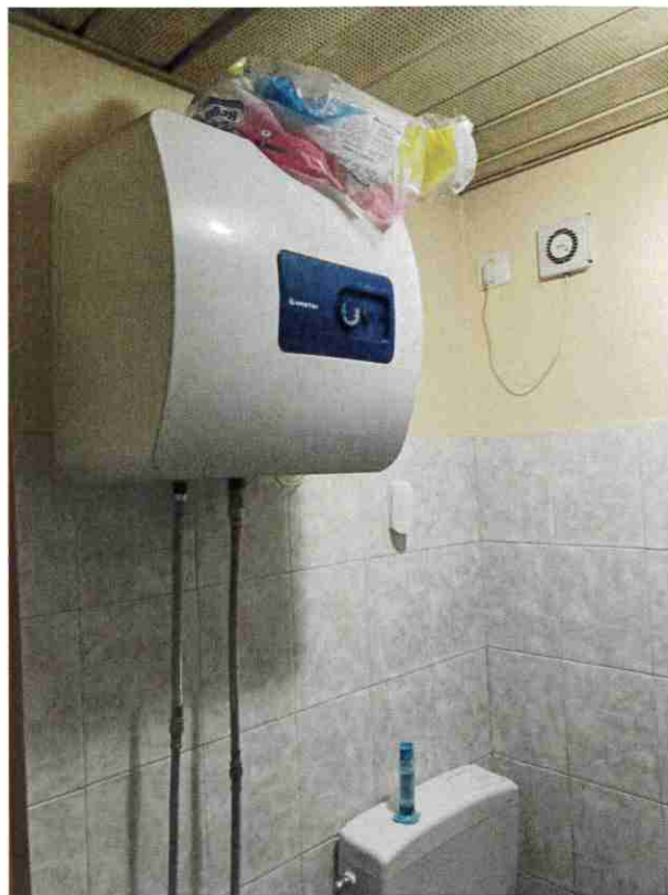
Particolari del locale bagno e del boiler elettrico per la produzione di acqua calda; presenza di infisso ligneo tamburato.
