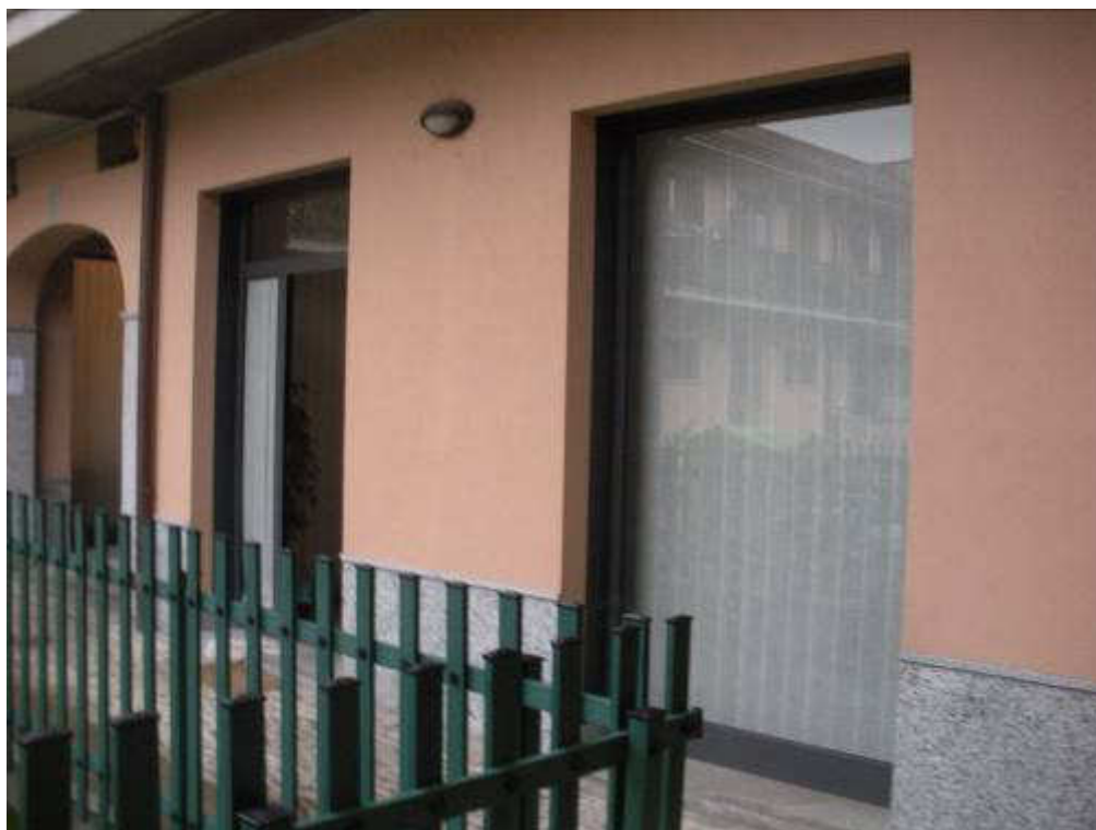
Fotografia 02 – Ingresso da cortile interno.
