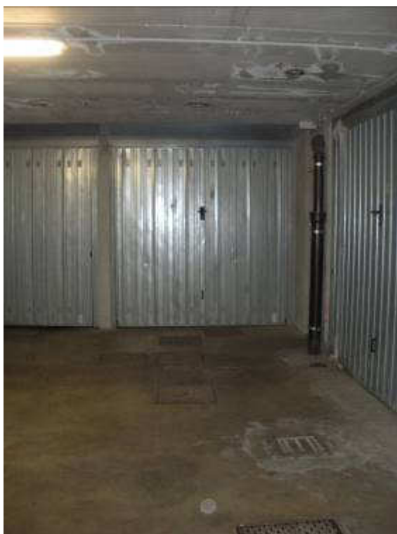
Fotografia 11 – Basculante box sub. 63 (doppio in lunghezza) – Non è stata possibile la visione interna dello stesso.
