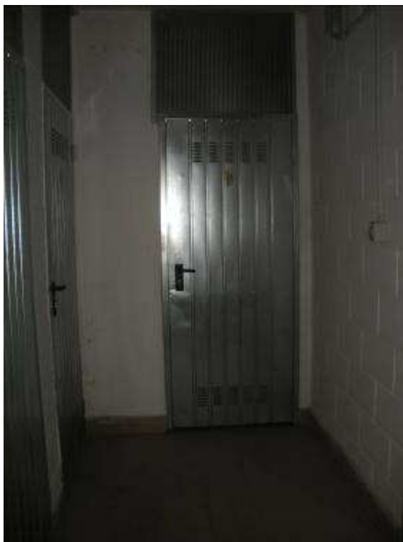
Fotografia 10 – Porta accesso locale Cantina sub. 51 (Non è stata possibile la visione interna)
