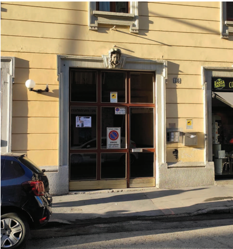
Foto n. 2 – Ingresso al condominio
