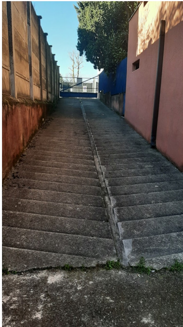
Foto n.2 – rampa carrabile di via Monte Carso civico 26
