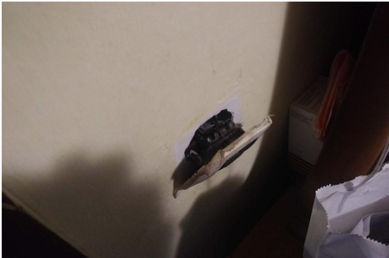
Foto n. 22 – Dettagli degrado e/o carenza di manutenzione impianto elettrico.
