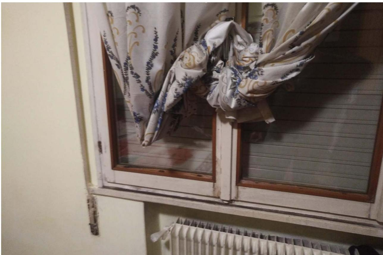
Foto n. 20 – Dettagli degrado e/o carenza di manutenzione infissi interni.
