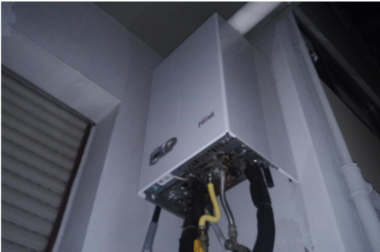
Foto n. 17 – Gruppo termico di fabbricazione Ferrol, installato sul balcone.
