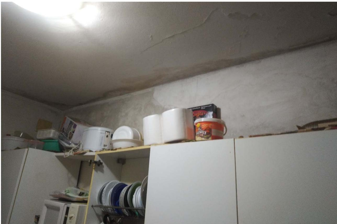
Foto n. 19 – Dettagli degrado e/o carenza di manutenzione tinte ed intonaci.
