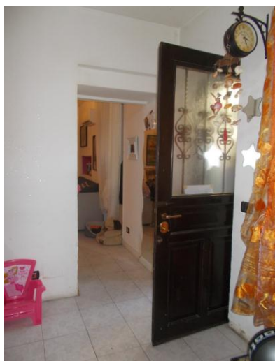
32. Particolare portoncino di ingresso
