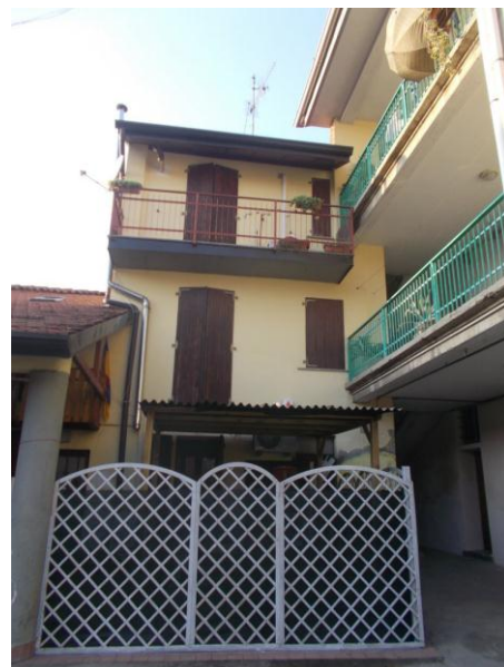
6. Facciata esterna (corpo alto)
