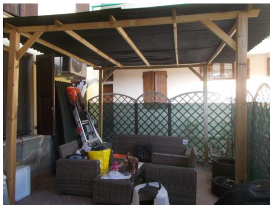
7. Area coperta (tettoia di ingresso)
