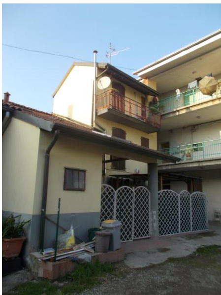
5. Facciata esterna (corpo basso)
