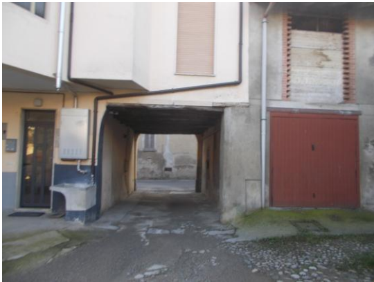
1. Ingresso alla corte comune (verso strada)
