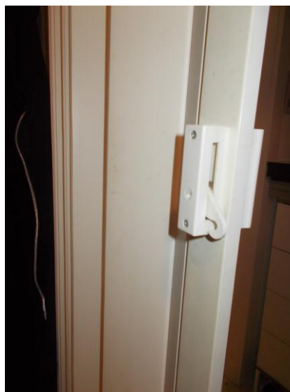
44. Porta di ingresso alla camera
