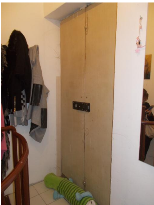
55. Zona di arrivo della scala con porta di collegamento alla scala comune (altra proprietà)
