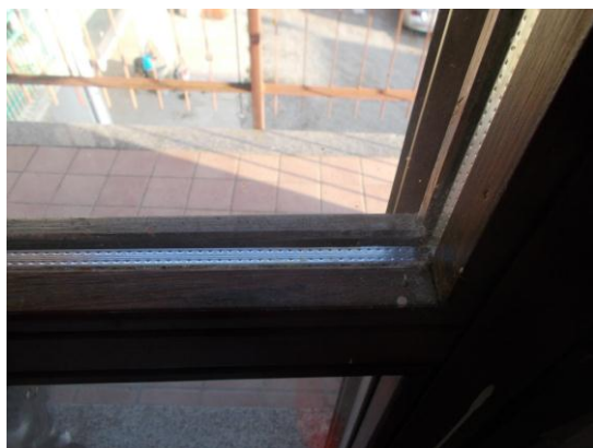
63. Dettaglio serramento esterno balcone
