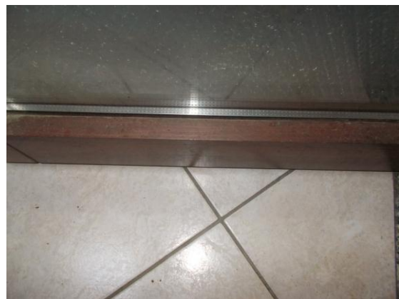
28. Dettaglio del serramento esterno
