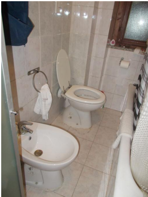
49. Interno del bagno
