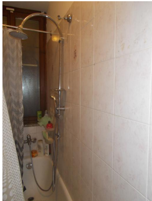
50. Interno del bagno
