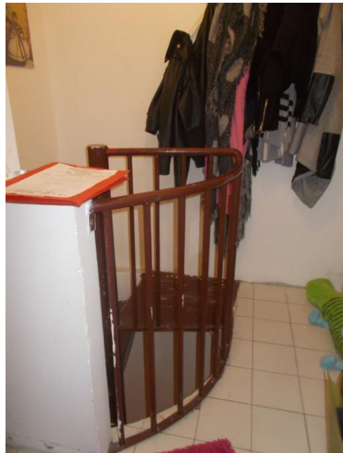
54. Zona di arrivo della scala al piano 2°
