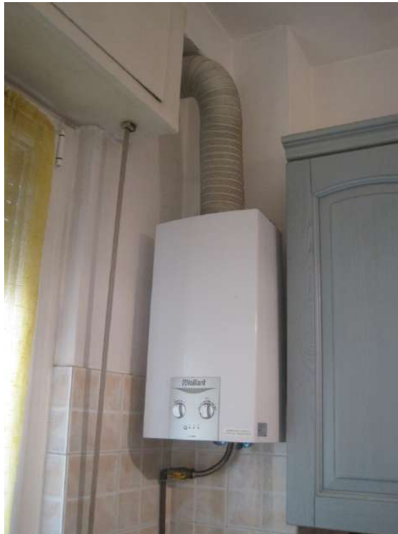
Caldaia murale per la produzione dell'acqua calda sanitaria
