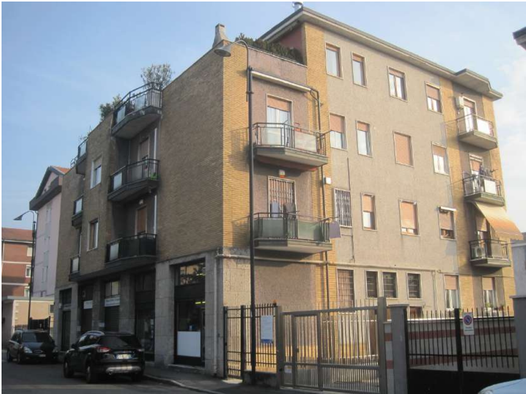
Fronte dell'edificio condominiale prospiciente Via Giuseppe Mazzini
