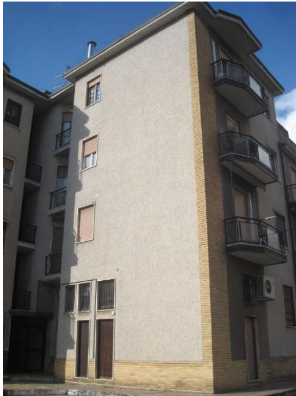
Retro dell'edificio condominiale prospiciente il cortile interno
