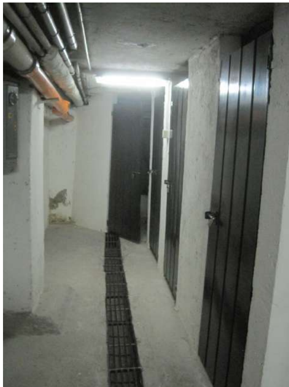
Corridoio delle cantine
