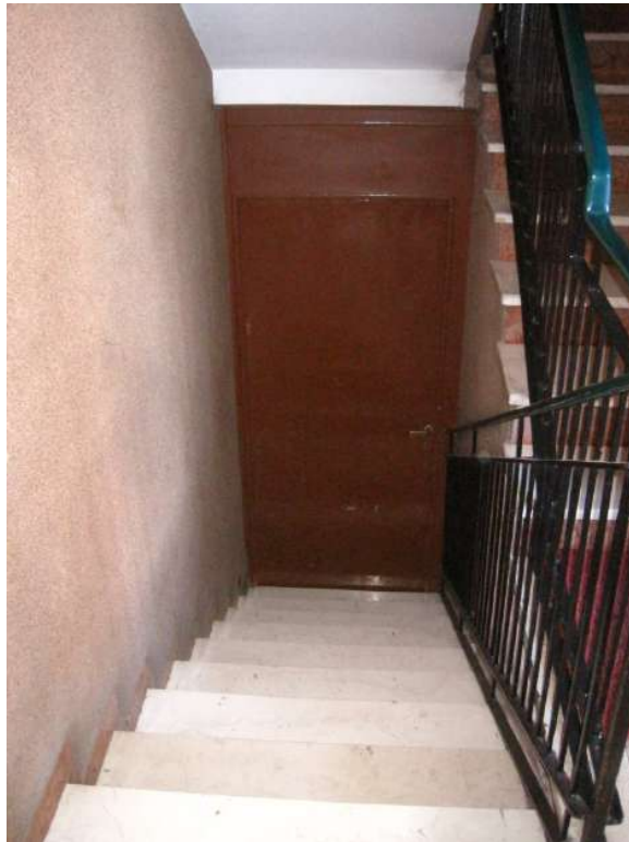
Scala di accesso al piano seminterrato dell'edificio
