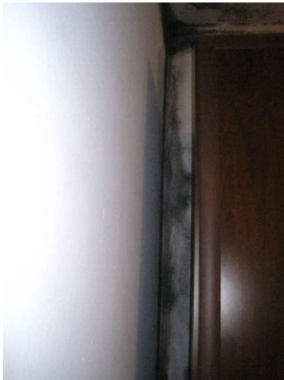
Dettaglio – Muffe in corrispondenza delle pareti Sud ed Est
