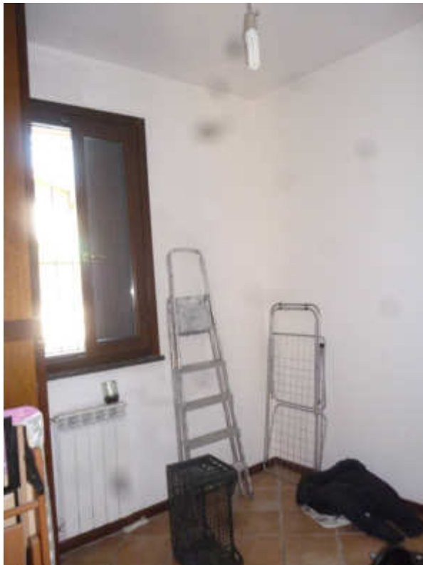
FOTO 10 – Camera con affaccio su Via Allende, particolare
