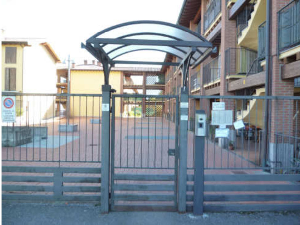
FOTO 3 – Ingresso pedonale lato OVEST
