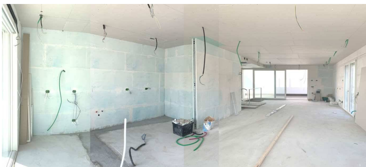
Foto nn. 45-46-47. Piano Quarto Sottotetto. Sottotetto
