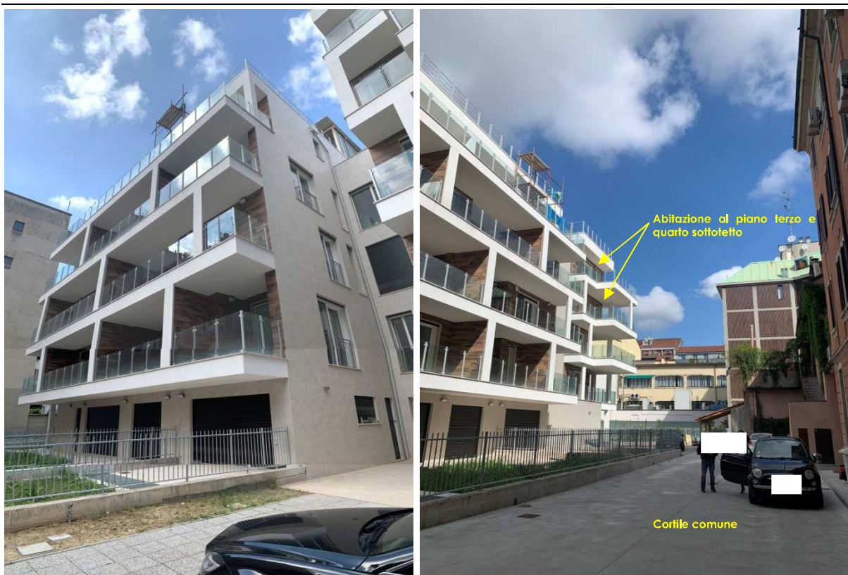
Foto nn. 7-8. Palazzina condominiale
