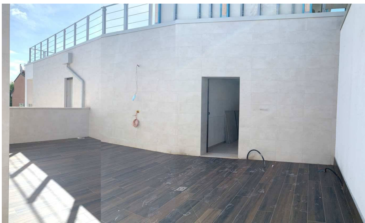
Foto nn. 38-39. Piano Quarto Sottotetto. Terrazzo
