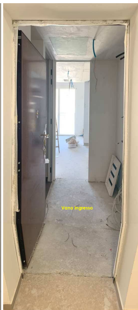
Foto nn. 15-16. Piano Terzo. Ingresso abitazione
