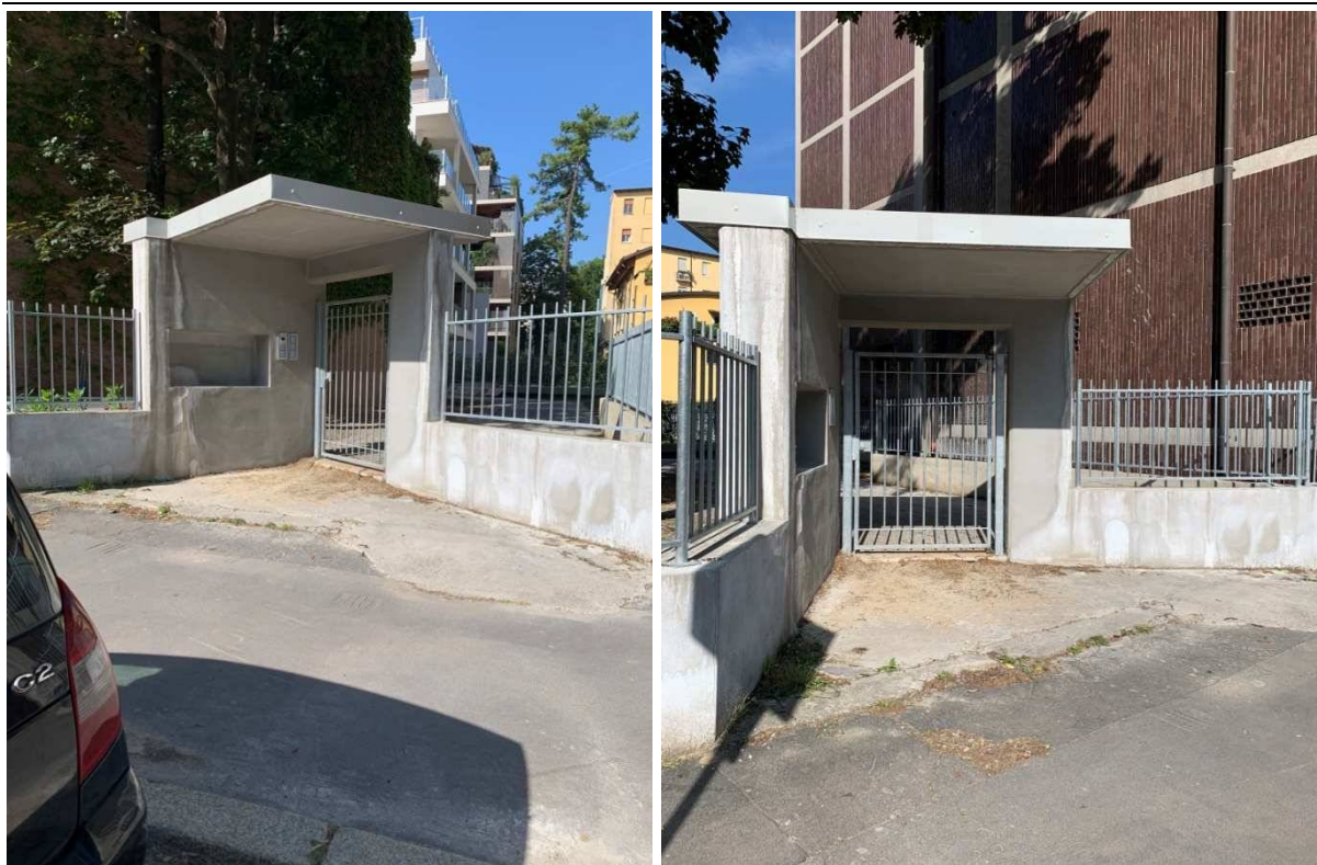
Foto nn. 4-5. Ingresso condominiale pedonale da Via Montevideo n. 11. In fase di completamento
