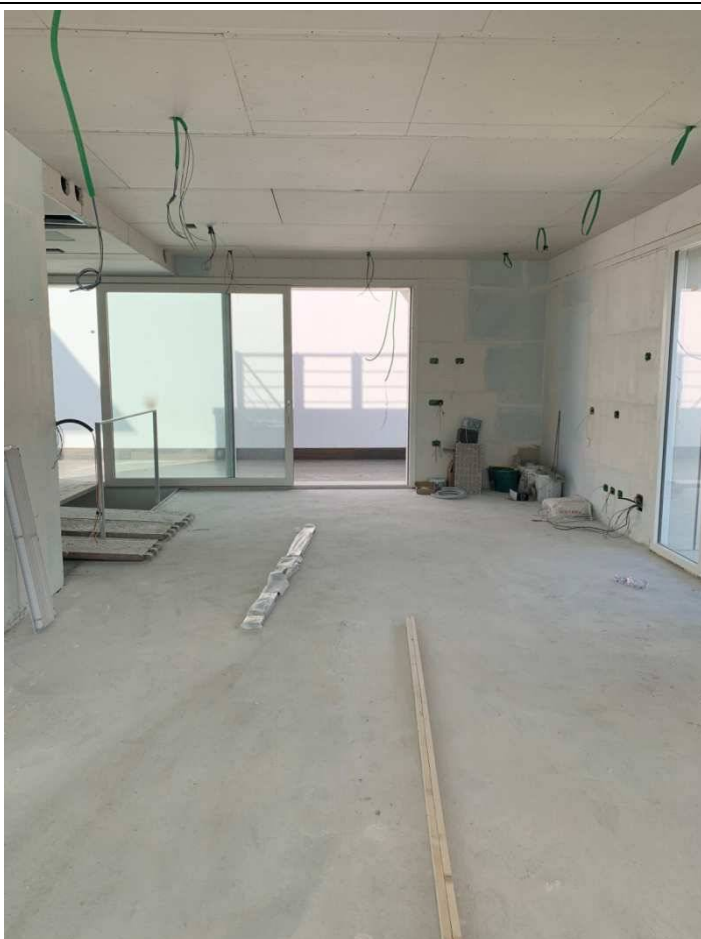
Foto n. 48. Piano Quarto Sottotetto. Sottotetto
