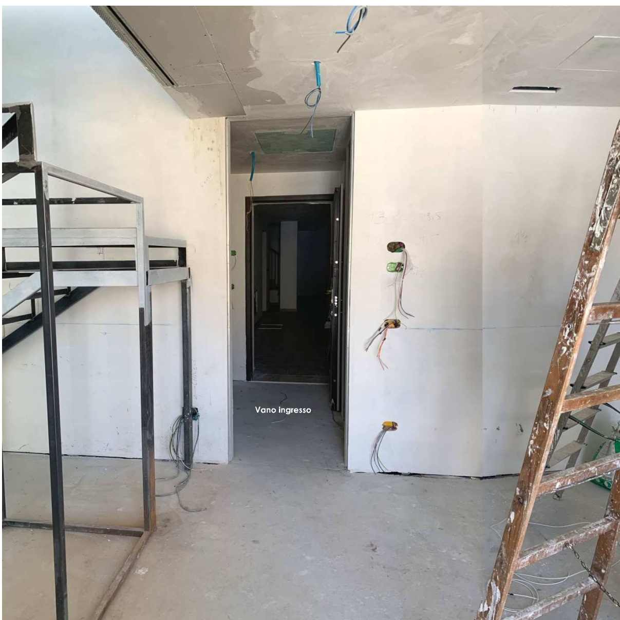
Foto nn. 21-22. Piano Terzo. Vano studio
