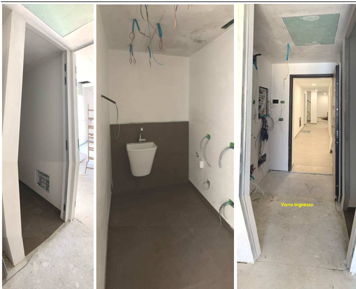
Foto nn. 17-18-19. Piano Terzo. Bagno ad uso lavanderia e vano ingresso
