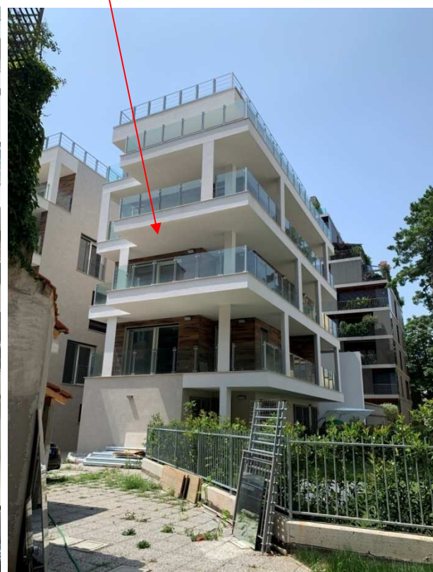
Foto nn. 8-9-10. Palazzina condominiale
