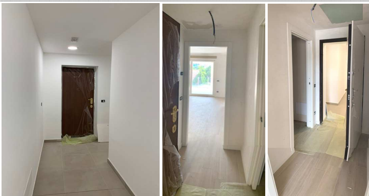
Foto nn. 17-18-19. Piano Terzo. Vano ingresso
