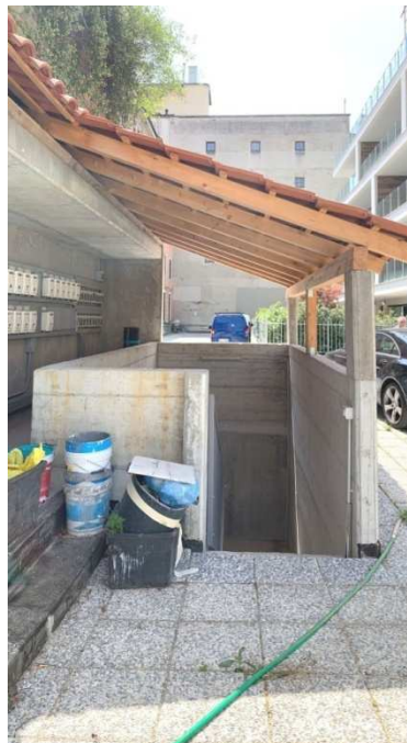
Foto nn. 4-5-6-7. Box auto al piano S1, facente parte integrante della palazzina condominiale denominata "Residenze Parco Solari". Cortile condominiale, accesso carrabile comune ai piani interrati e scala esterna (scala B) di collegamento ai piani S1-S2
