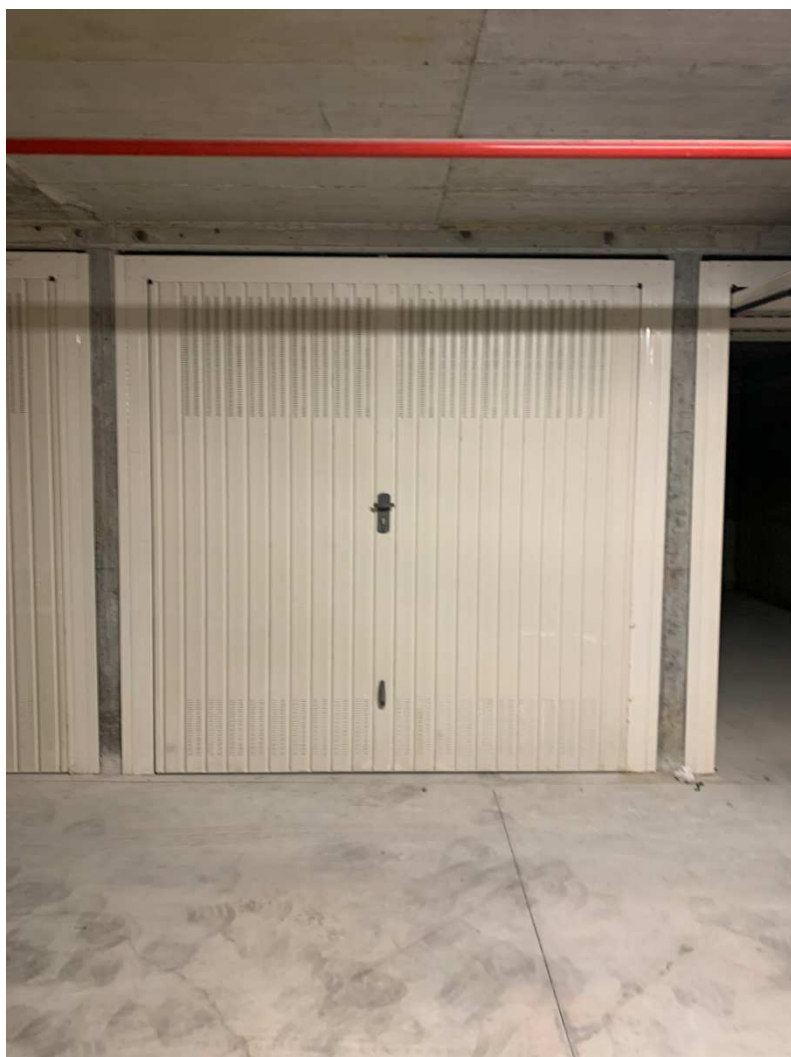
Foto nn. 13-14-15. Piano Secondo Interrato. Box auto
