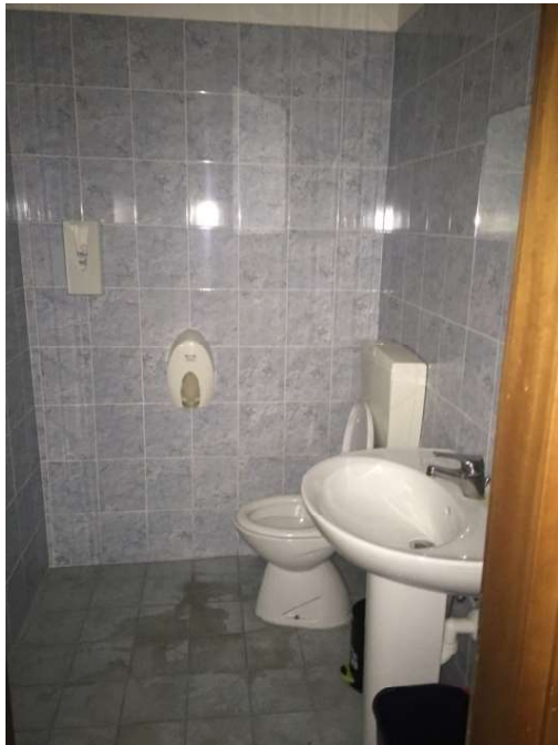
particolare ulteriore wc
