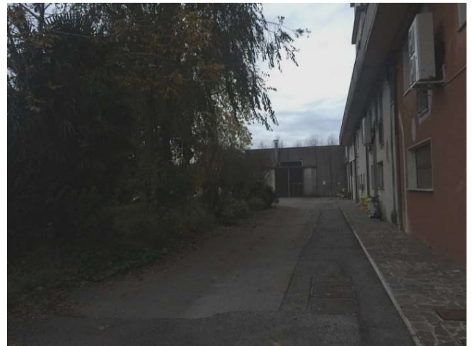
vista esterna area condominiale (mappale 182)
