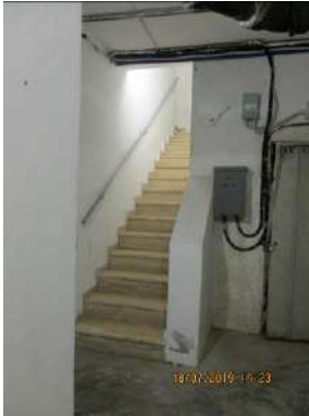
15 Accesso seminterrato cantine
