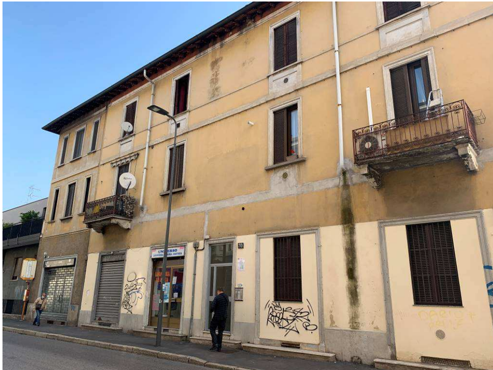
Fotografia n. 1 – Vista della facciata principale del Condominio Via Rismondo n. 30 di Milano
