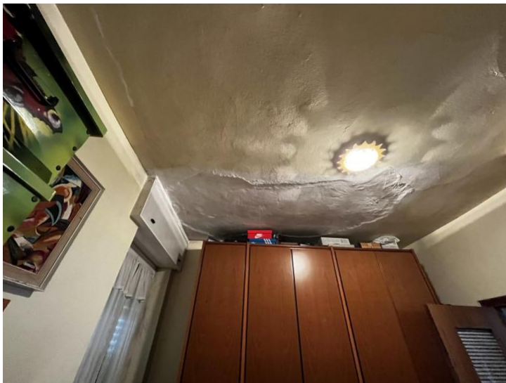
Immagini 16 e 17. Dettagli della camera da letto, distacco dell'intonaco del plafone.
