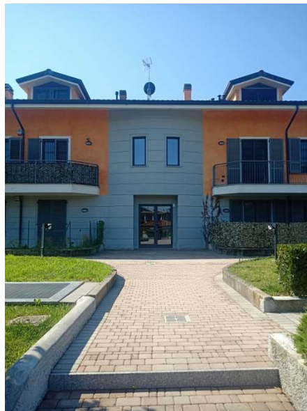
Particolare esterno edificio
