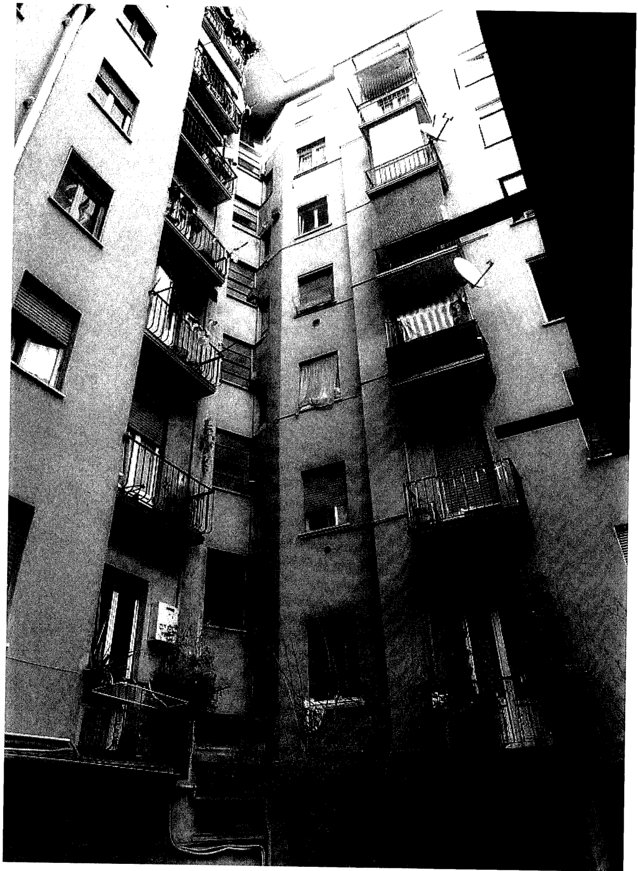
FACCIATA SU CORTILE INTERNO
