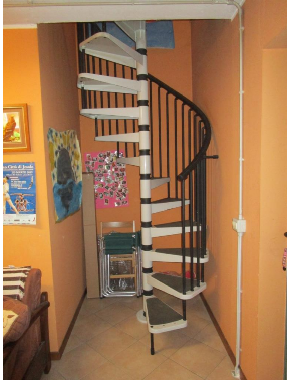
Foto 14 – Scala "a chiocciola" di collegamento tra il locale soggiorno e la cantina
