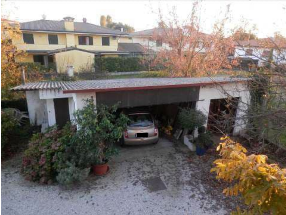
Foto 5-6: Fabbricato accessorio lato Nord e lato Sud.
