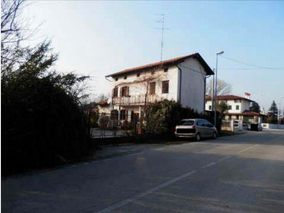
Foto 1-2: Fabbricato di abitazione lato Sud-Est e Nord-Est.
