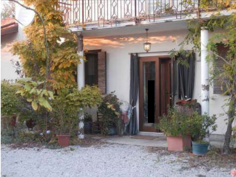
Foto 9-10: Fabbricato di abitazione: ingresso.
