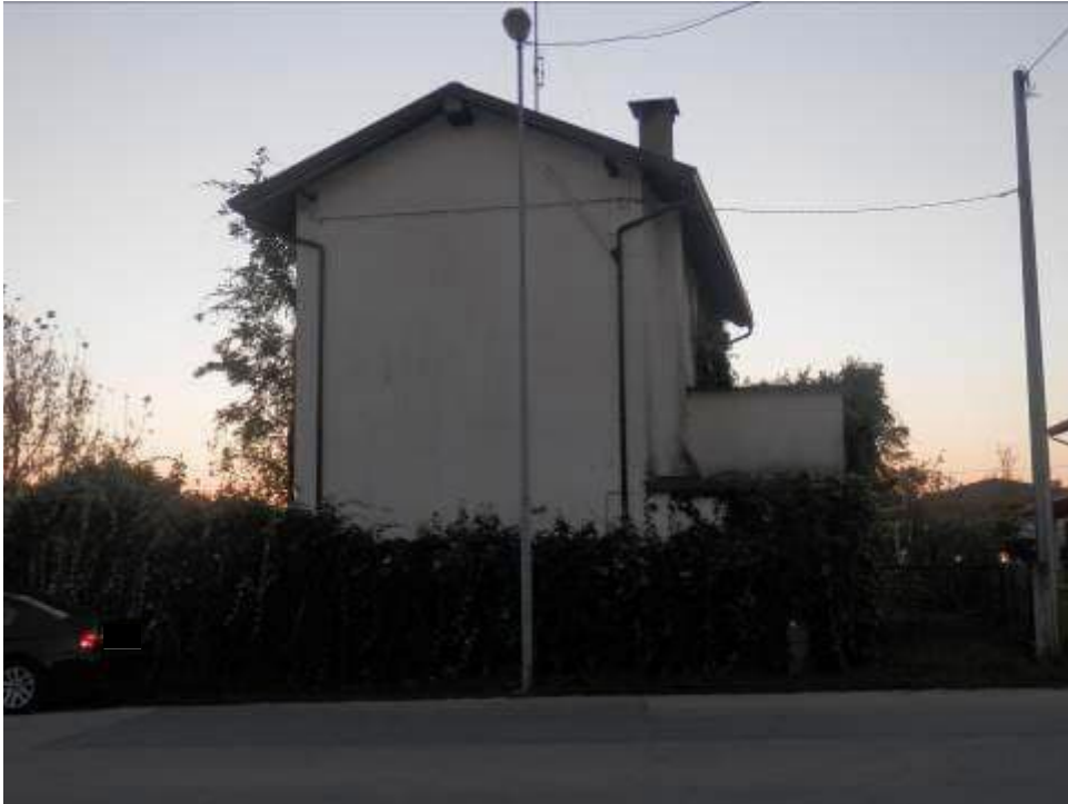
Foto 3-4: Fabbricato di abitazione lato Est e Nord-Ovest.
