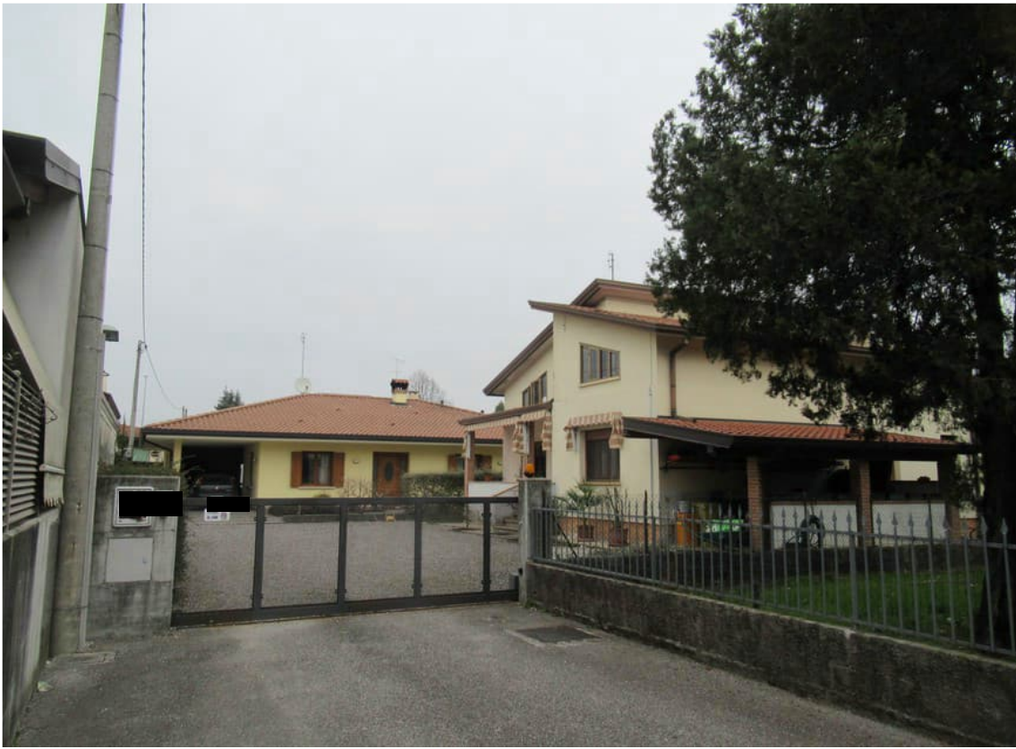
Foto 1: Accesso all'abitazione oggetto di esecuzione
