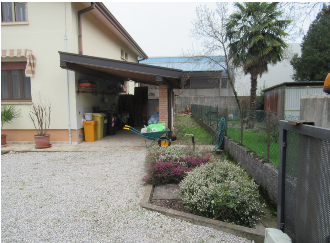
Foto 6: Portico lato ad Ovest
