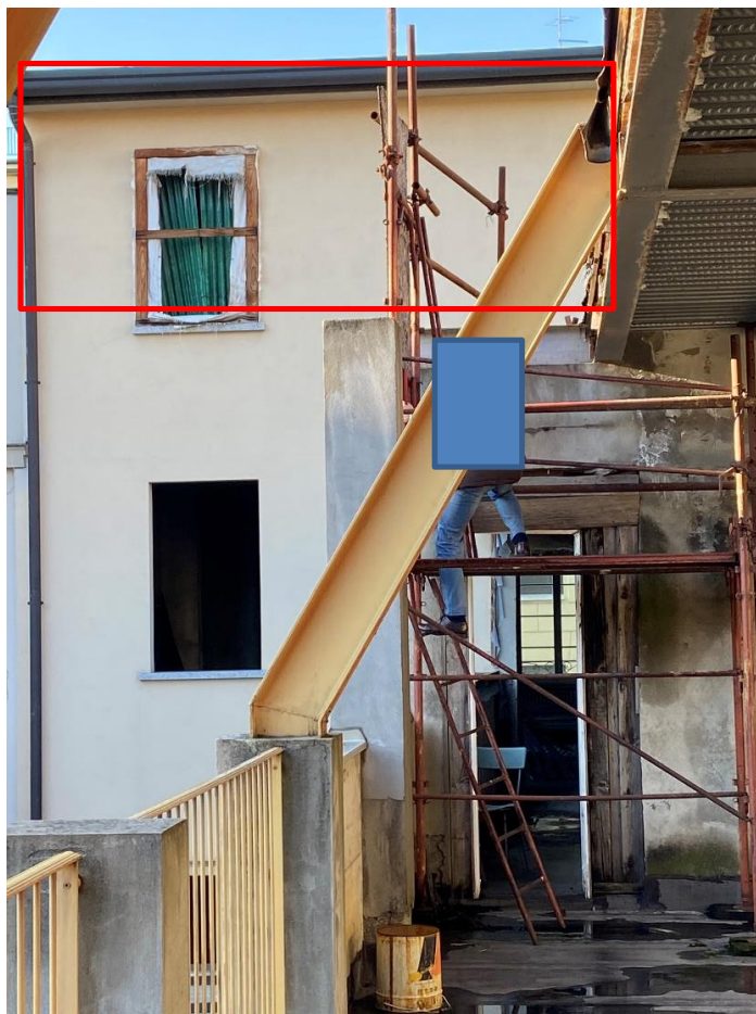
Vista dell'accesso alla porzione sottotetto
