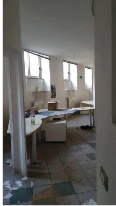
UFFICI PIANO SEMINTERRATO
