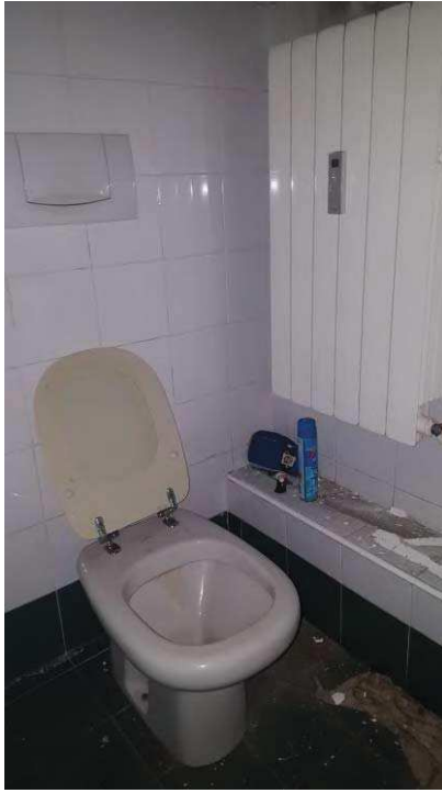
BAGNO UFFICI P SEMINTERRATO
