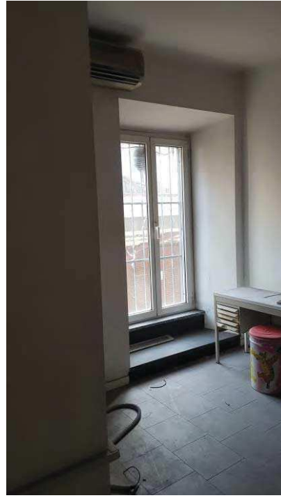
LOCALE TECNICO P 1
