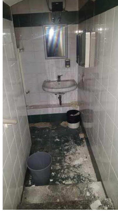
BAGNO UFFICI P SEMINTERRATO
