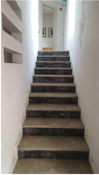
SCALA ACCESSO PIANO 1
