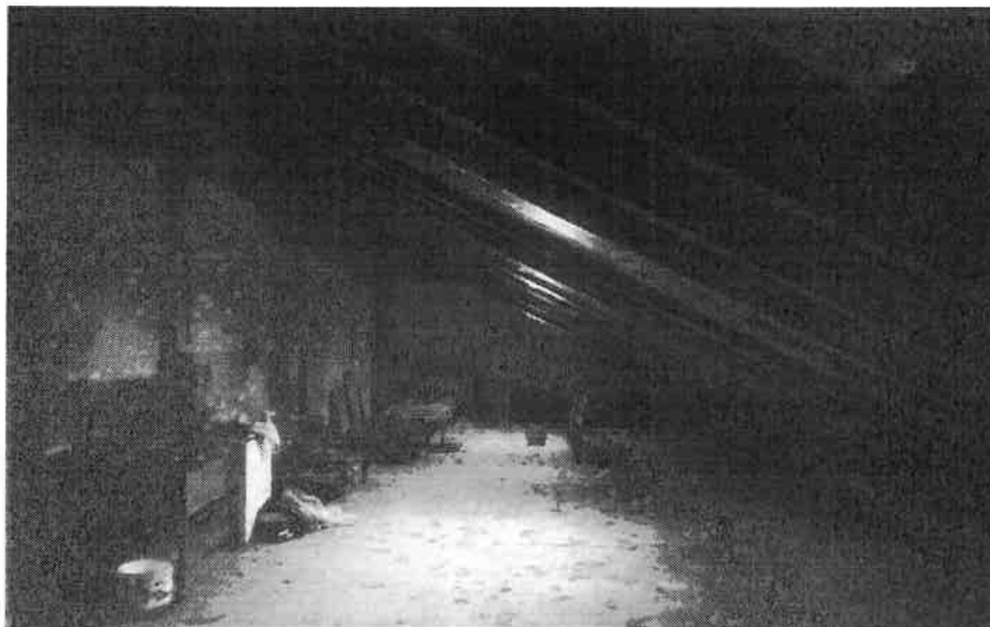
Fig.15: situazione piano sottotetto durante il sopralluogo del 11.05.2021 – foto 1
