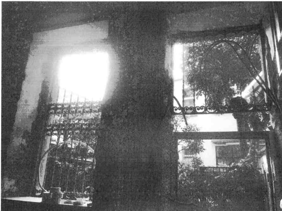
Fig.9: situazione piano terra durante il sopralluogo del 18.11.2019 – foto 2
