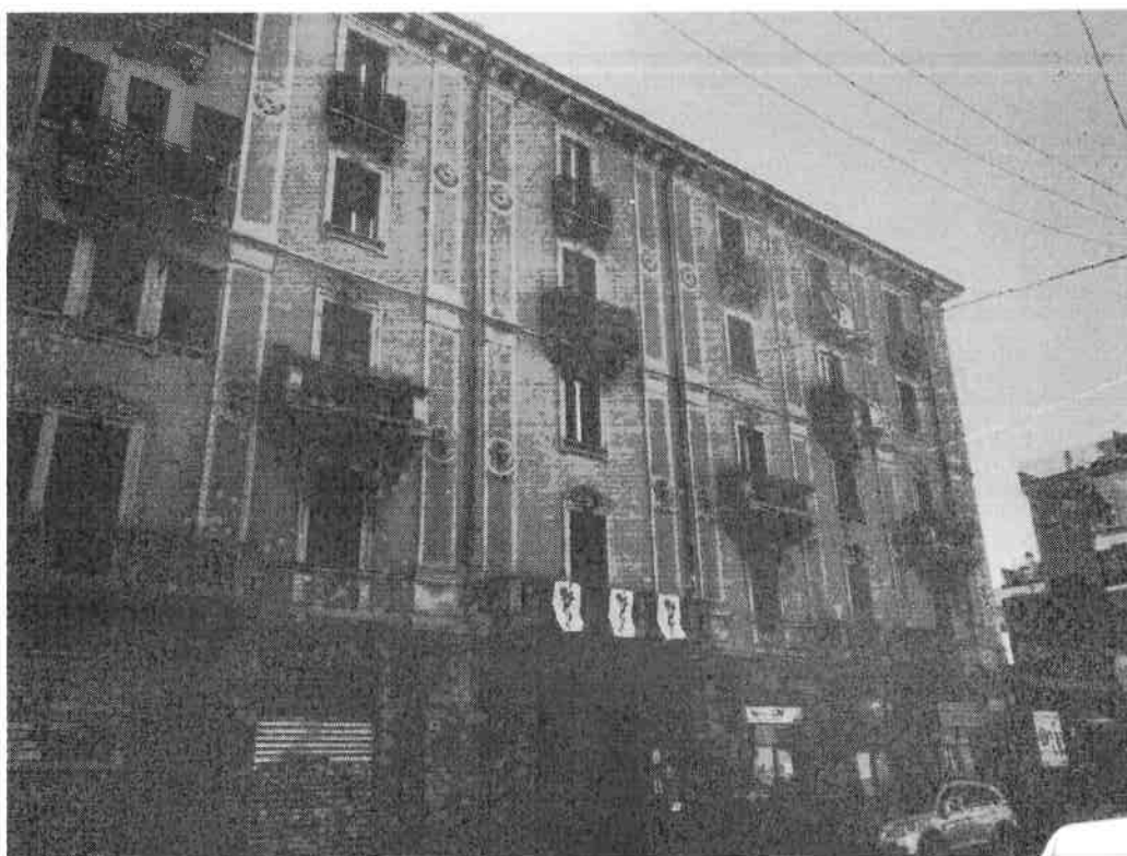
Fig.22: situazione prospetto lato via Padova durante il sopralluogo del 18.05.2021 – foto 2
