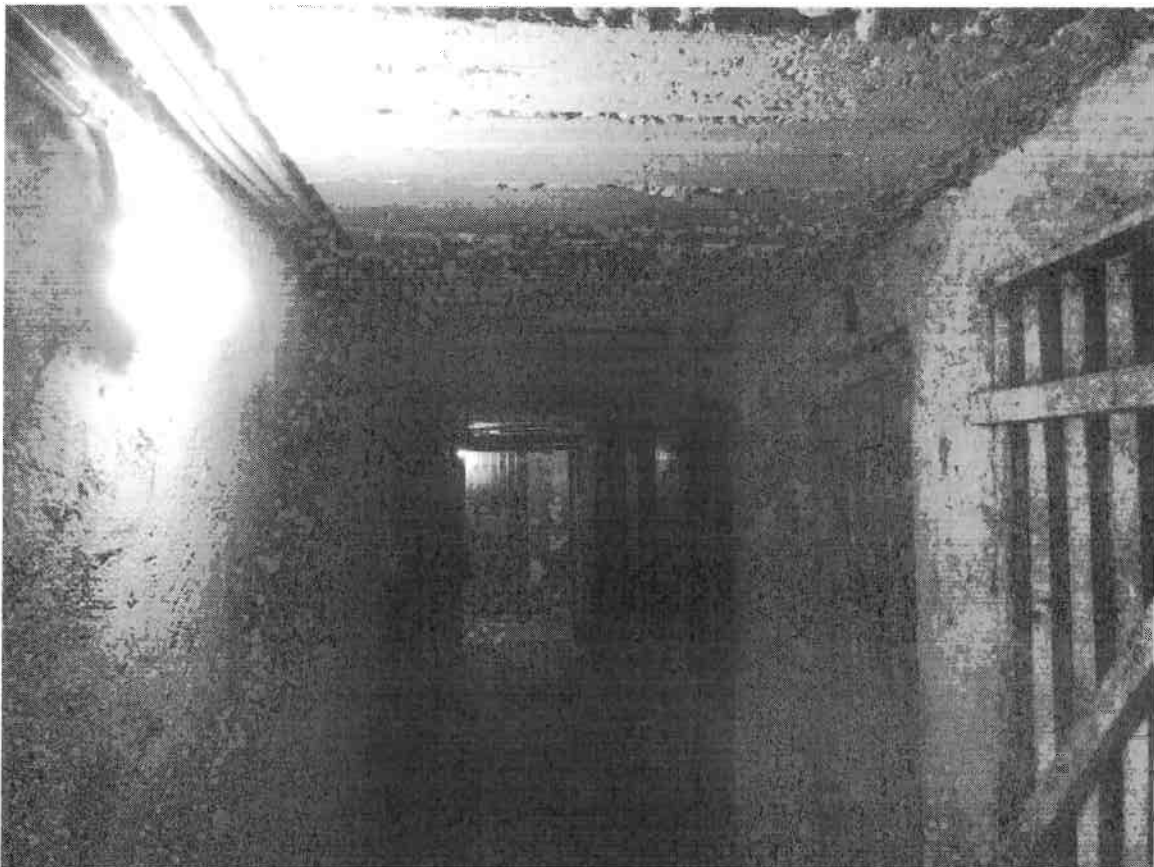
Fig.6: situazione piano interrato durante il sopralluogo del 18.11.2019 – foto 2
