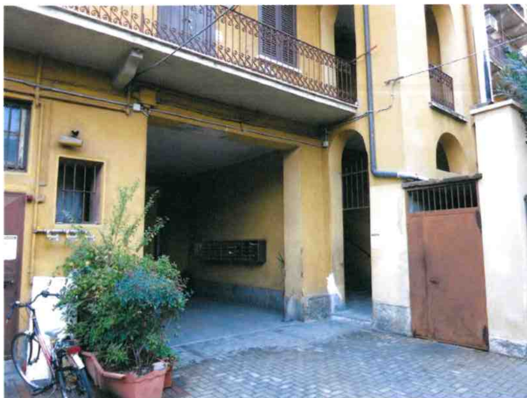
Cortile e ingresso a vano scala comune
