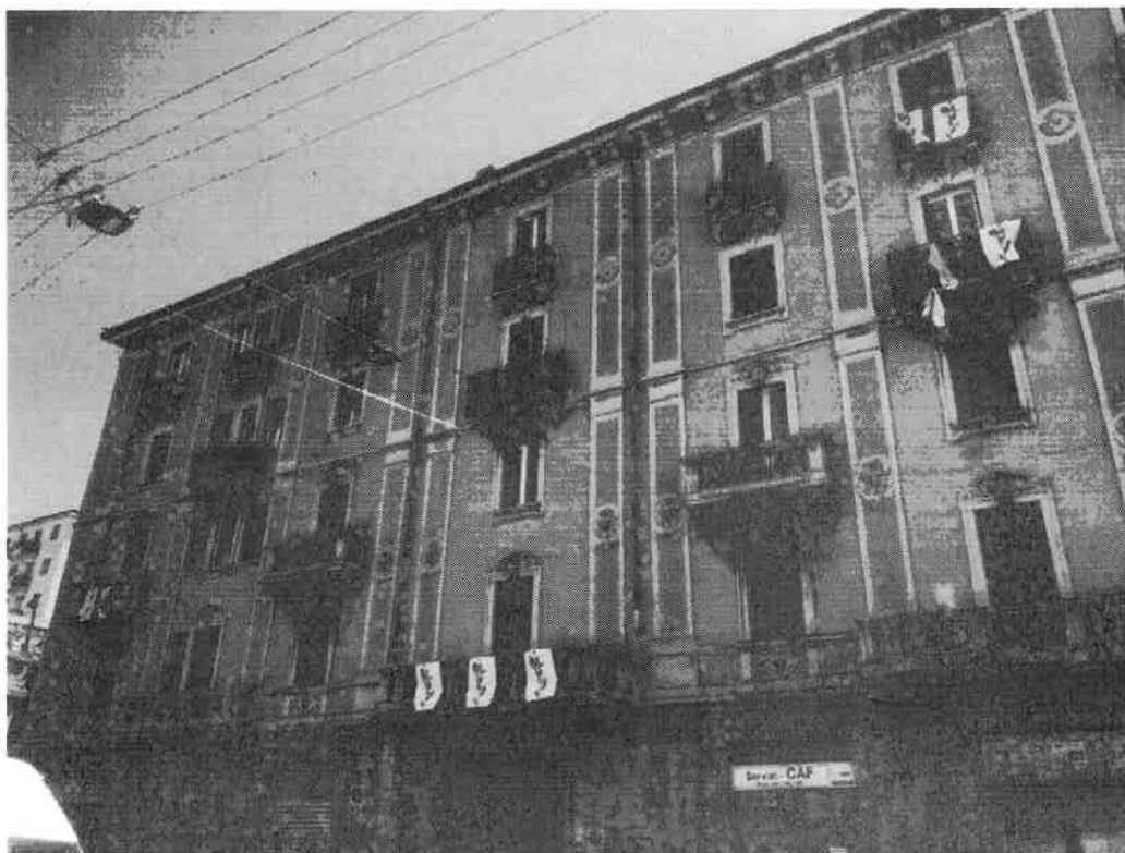
Fig.21: situazione prospetto lato via Padova durante il sopralluogo del 18.05.2021 – foto 1
