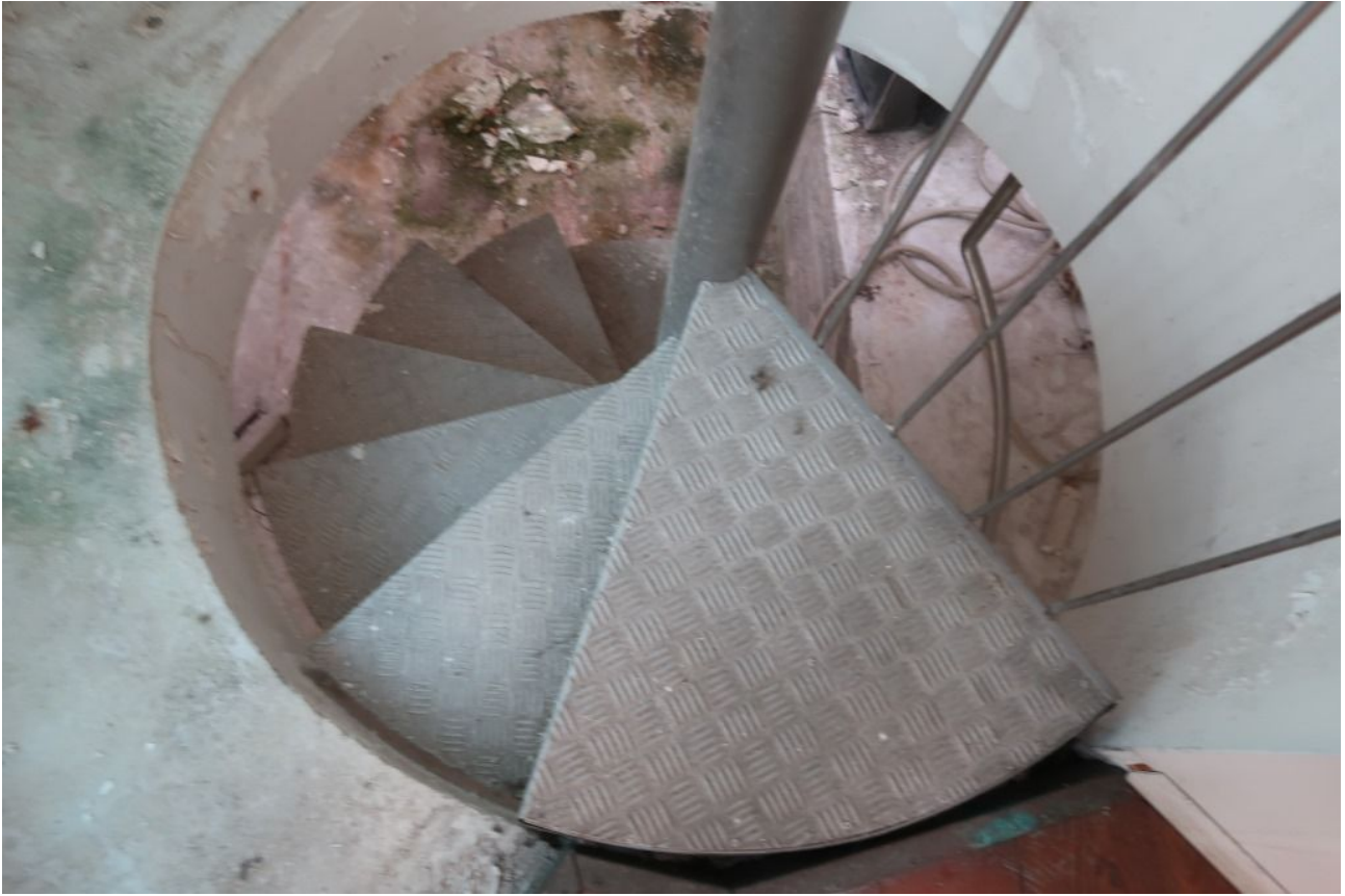
SCALA DI ACCESSO AL PIANO SEMINTERRATO
