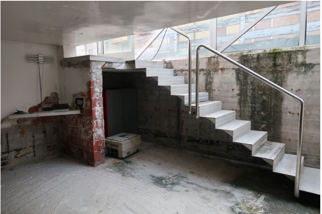
PIANO SEMINTERRATO FOTO 3
