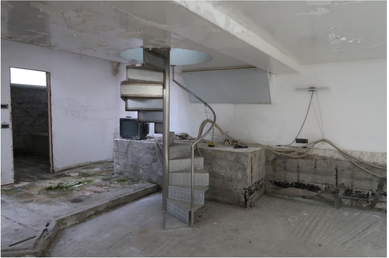
PIANO SEMINTERRATO FOTO 2
