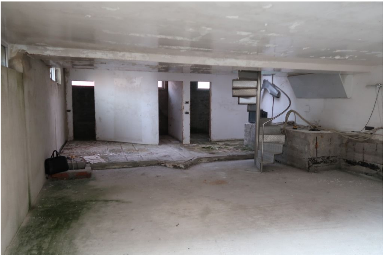
PIANO SEMINTERRATO FOTO 1
