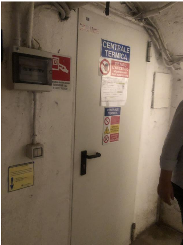
Vista ingresso per cantina al sub 61
