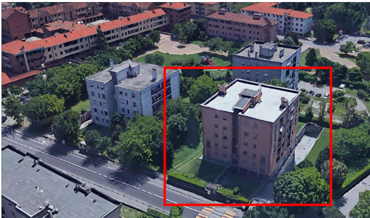
Fronte dell'edificio prospiciente la Pubblica Via
