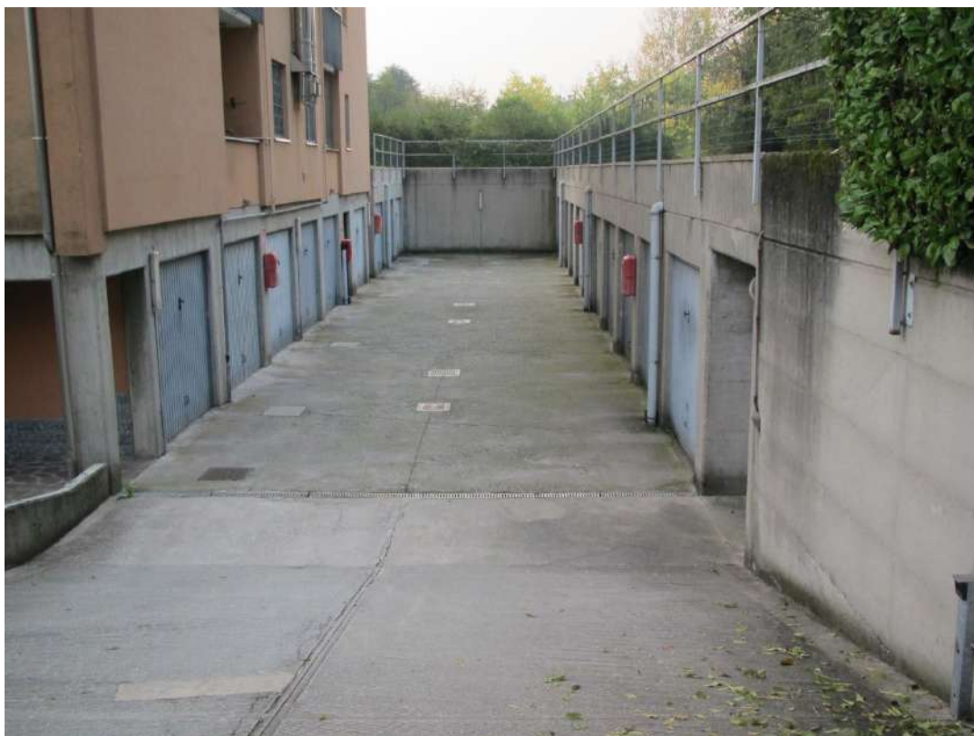
Corsello di manovra dell'autorimessa condominiale
