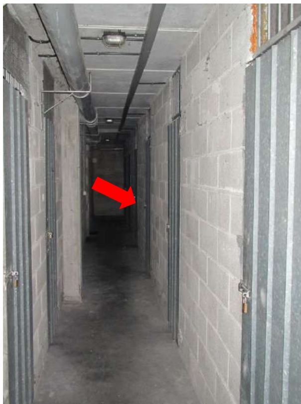
Corridoio delle cantine al piano seminterrato
