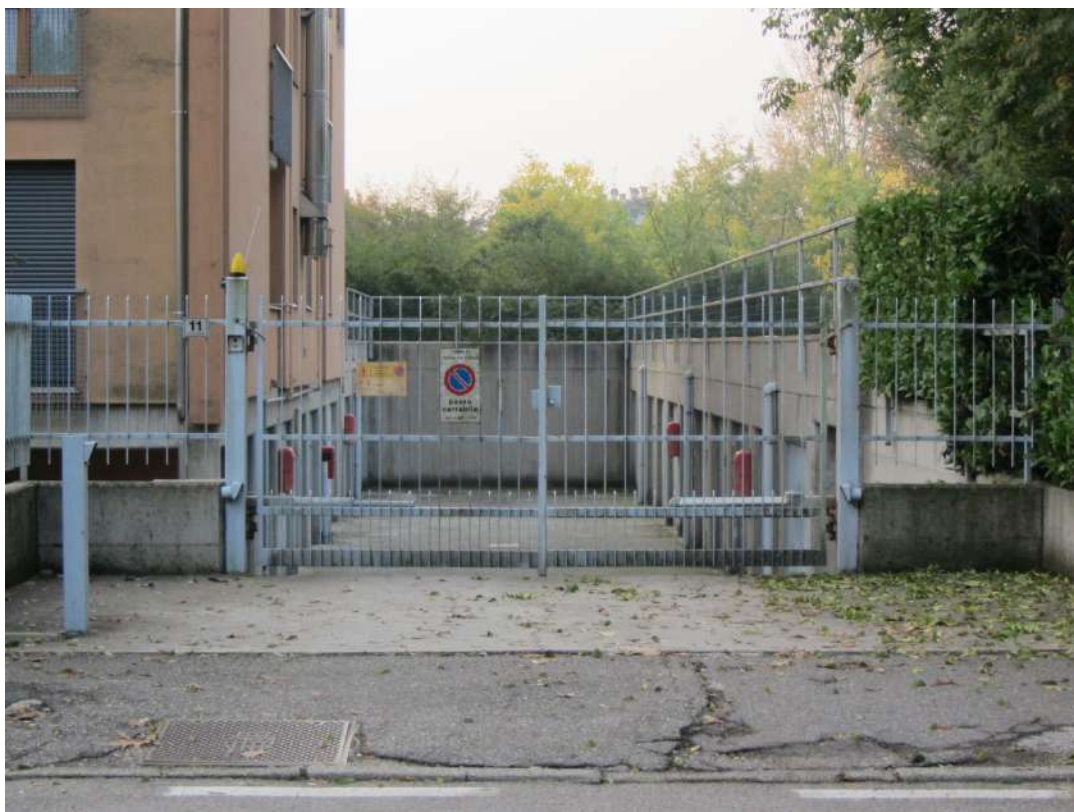
Ingresso carraio dell'edificio
