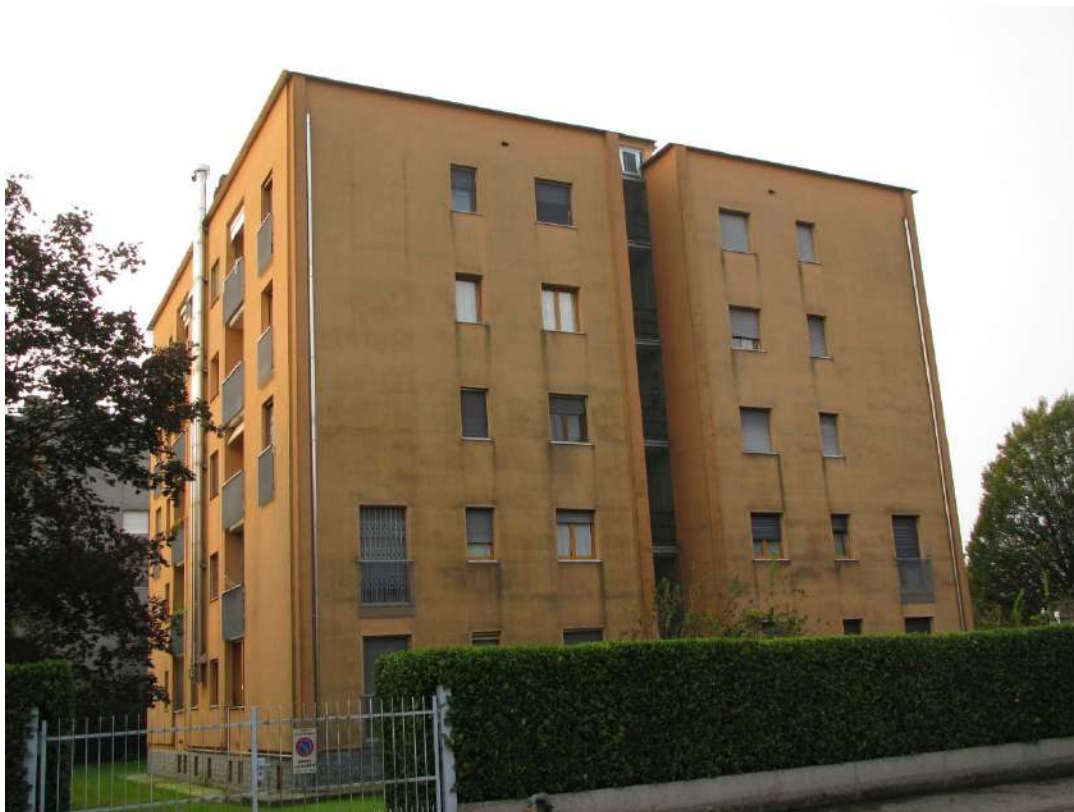
Fronte dell'edificio prospiciente la Pubblica Via
