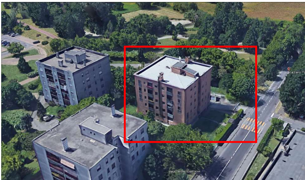
Fronti laterale e principale dell'edificio
