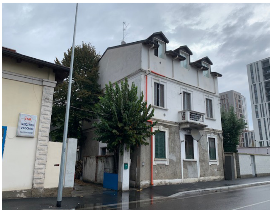
Vista esterna - fabbricato di riferimento
