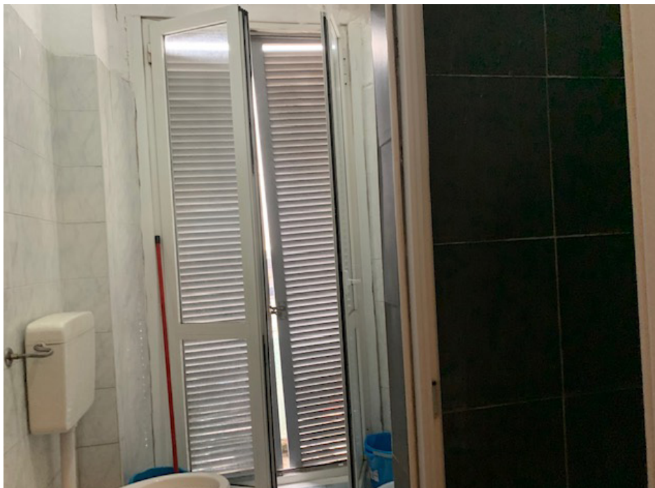
Vista esterna - bagno
