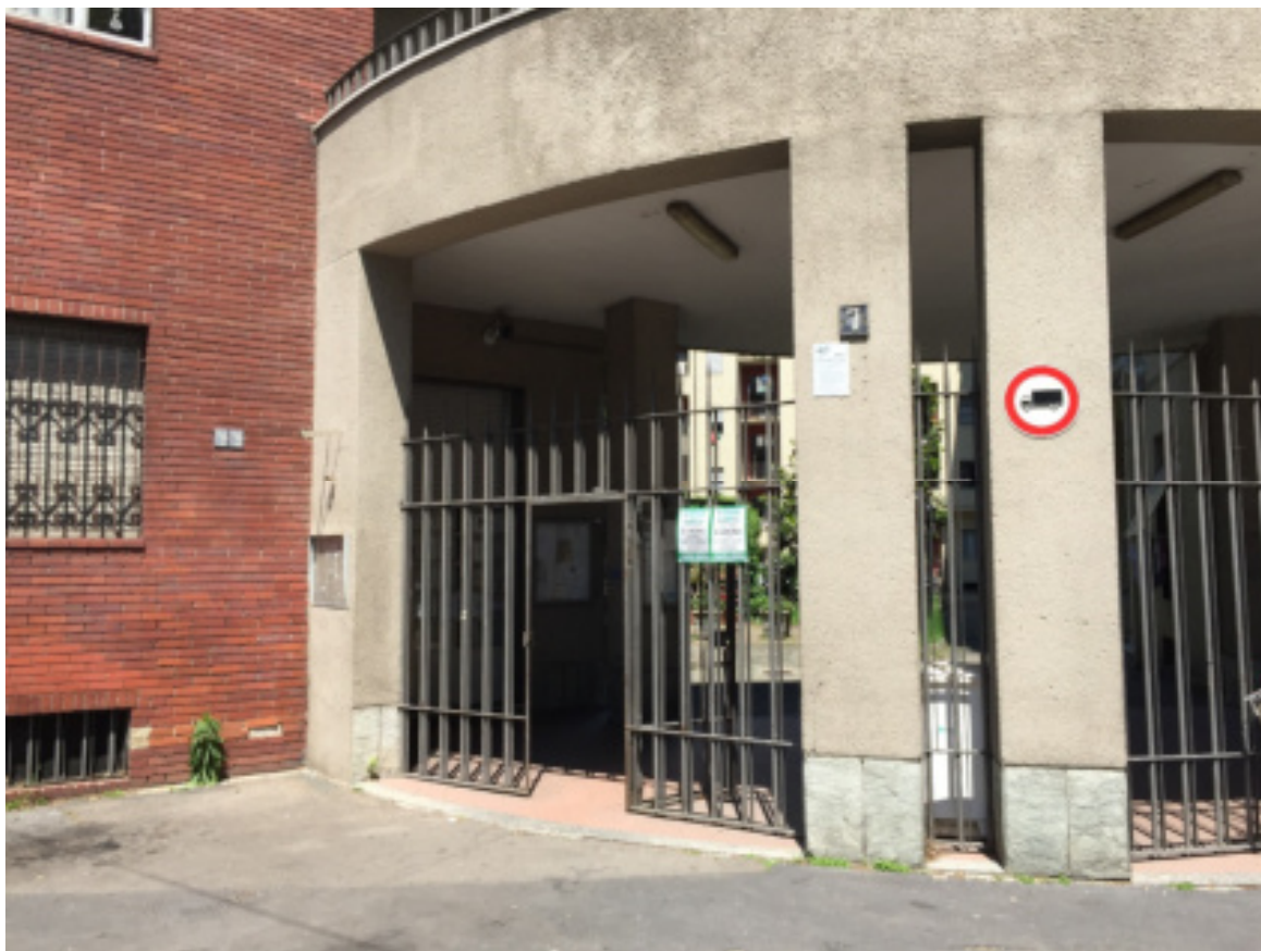
Foto 05 - Accesso al fabbricato al civico 7 di piazzale Cuoco
