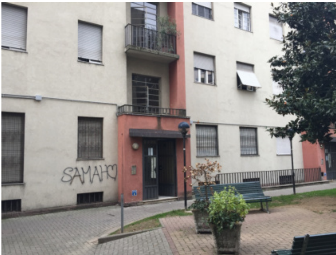
Foto 06 - Accesso alla scala dell'unità sul cortile comune
