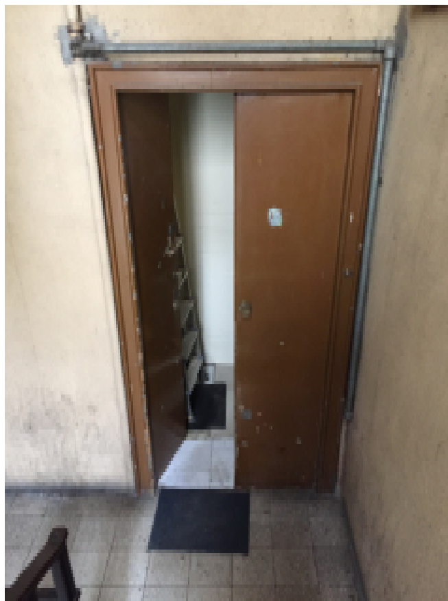
Foto 07 - Ingresso dal pianerottolo
