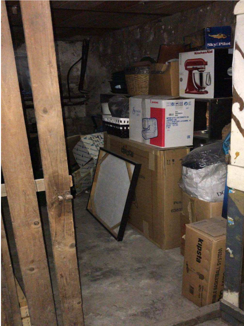
Fotografia n. 58 – Vista del locale cantina
