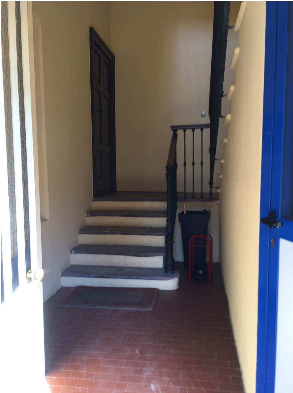
Fotografia n. 9 – Vista dell'atrio di ingresso al corpo scale con particolare, sulla sinistra, della porta di accesso alle unità immobiliari A-C
