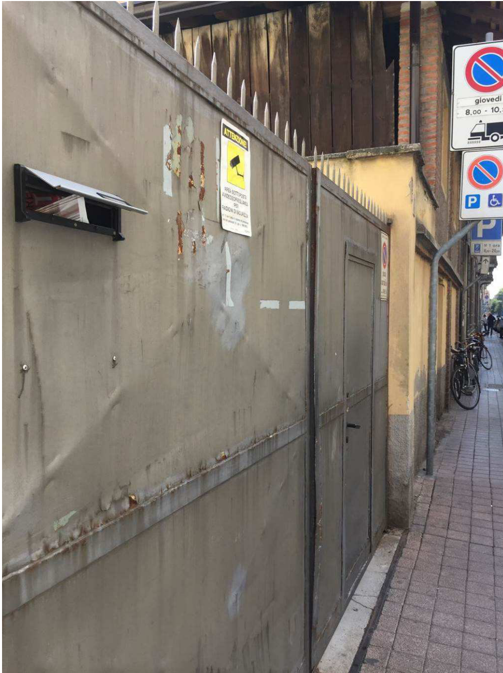
Fotografia n. 5 – Particolare dell'ingresso pedonale e carraio allo stabile sulla Via Giuseppe Garibaldi n. 17
