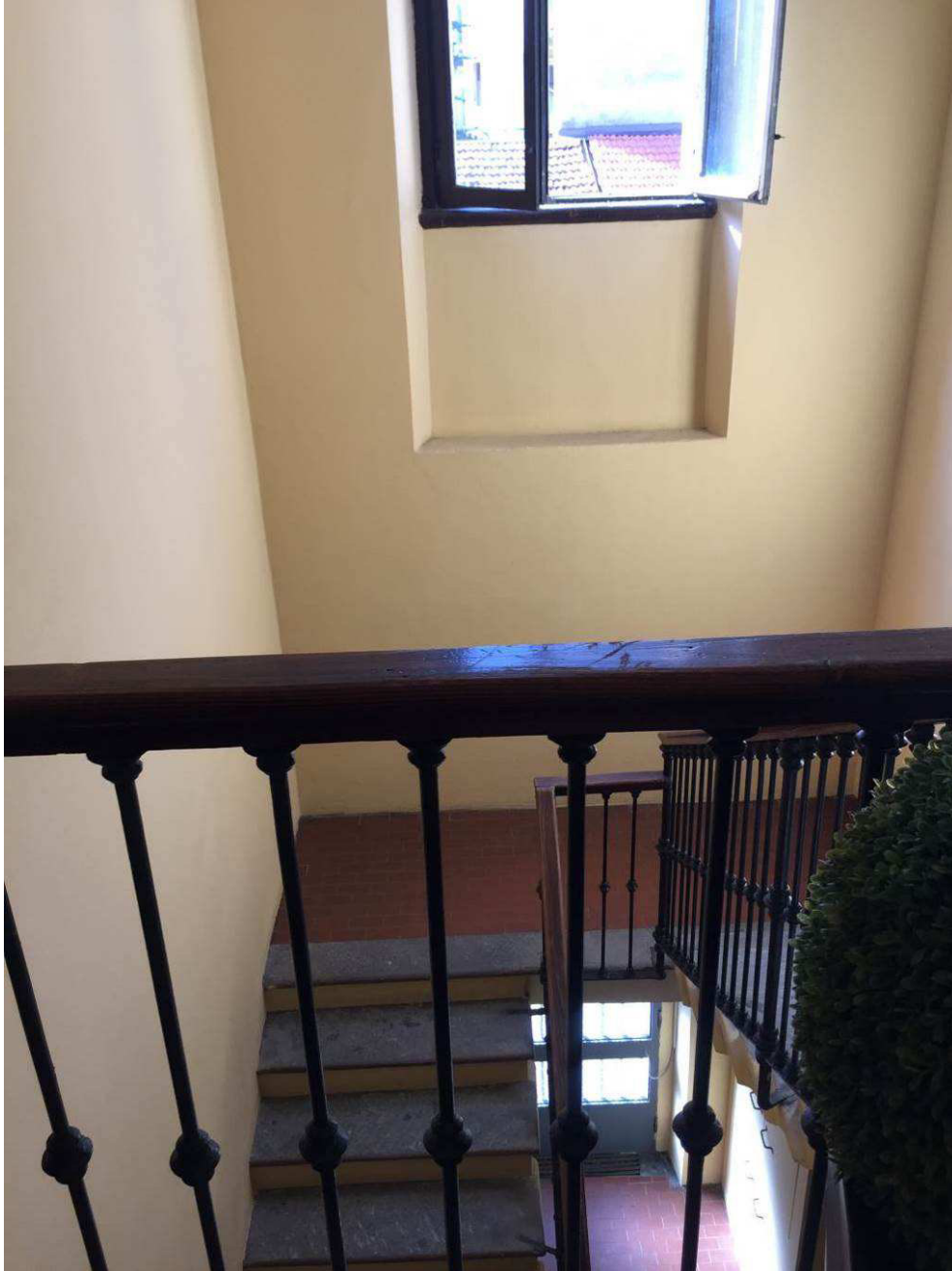
Fotografia n. 33 – Vista del corpo scale comune.
