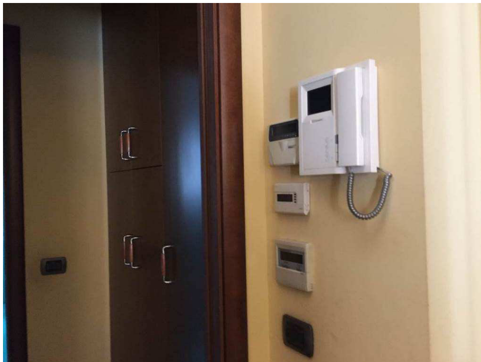
Fotografia n. 44 – Vista del locale disimpegno su cui affaccia il locale bagno
