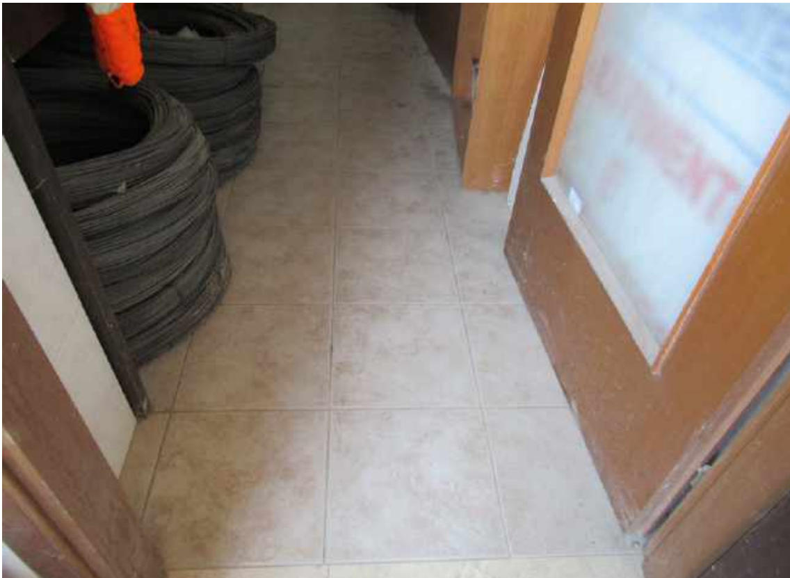
Foto 14: Particolare pavimento anti wc
