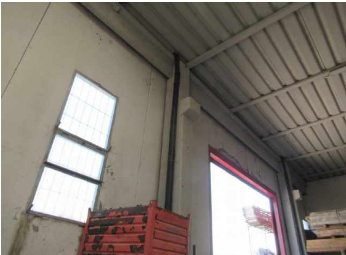
Foto 10: Particolare scarico acque di copertura
