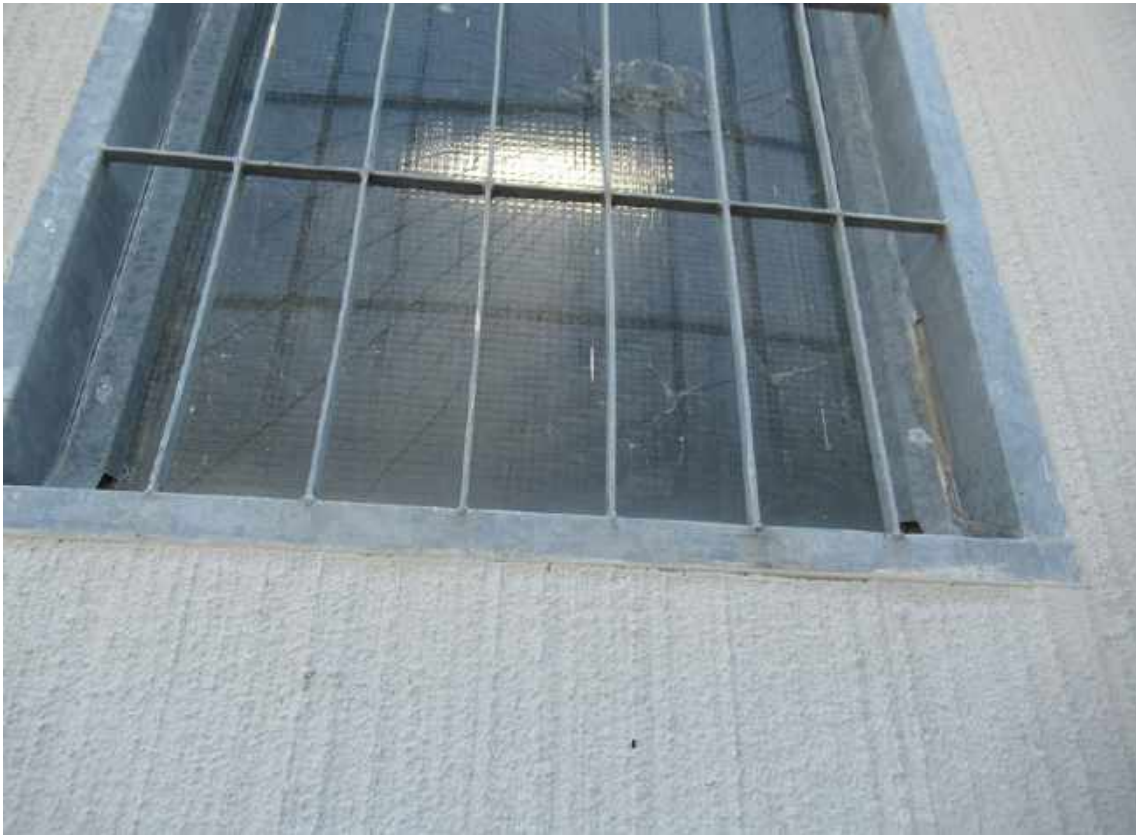
Foto 17: Particolare serramenti di finestre
