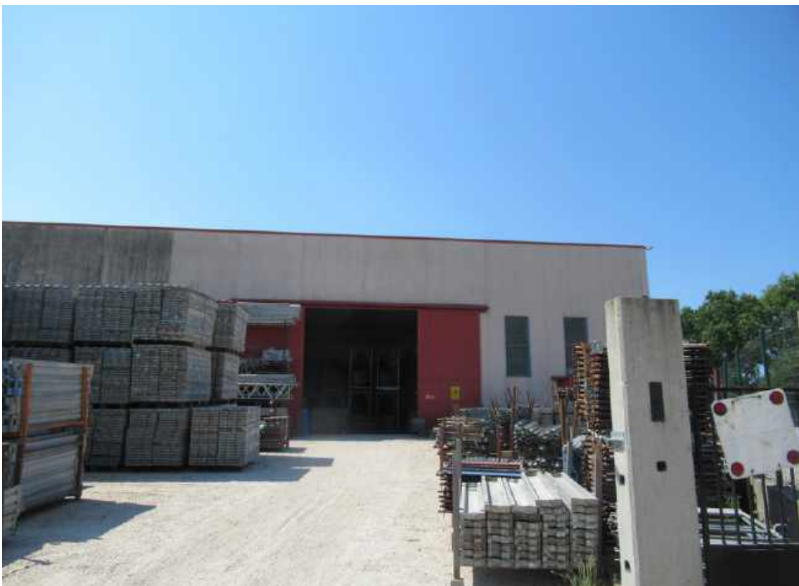
Foto 4: Prospetto Nord magazzino
