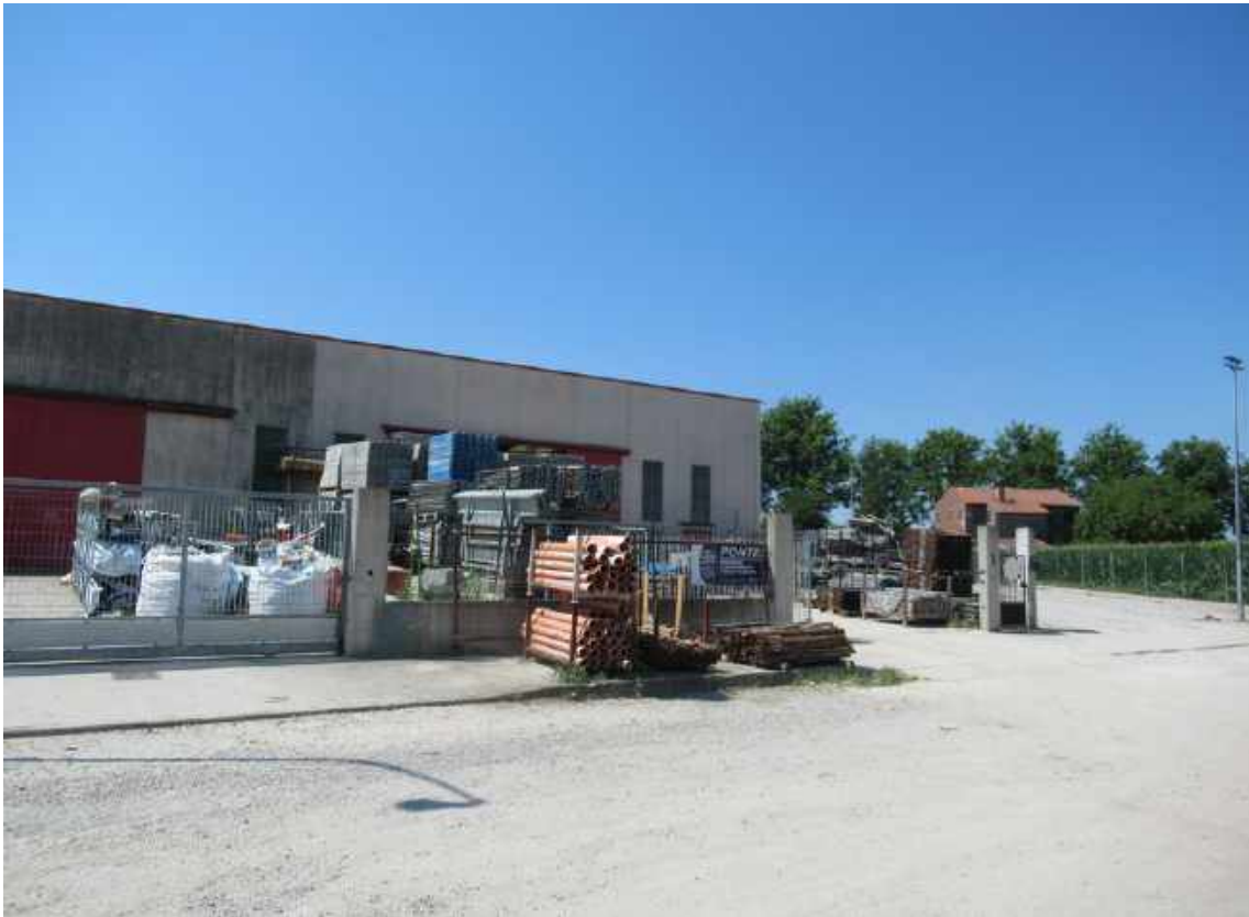
Foto 1: Magazzino visto dalla strada di lottizzazione
