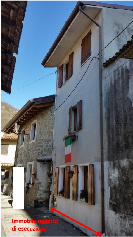
Vista del fabbricato dalla strada
