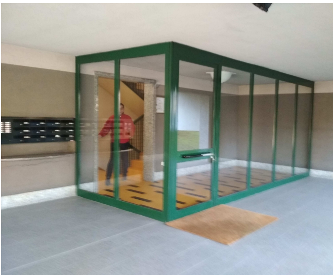
Foto n. 3 – Ingresso al fabbricato
