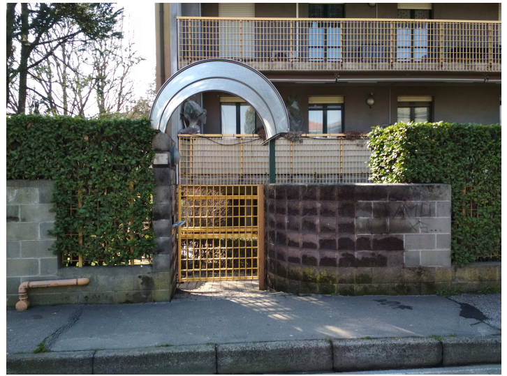
Foto n. 2 – Ingresso al condominio
